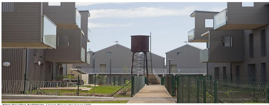
Figure 35: Château d'eau Quartier Nouvel AIR Source : https://vivreavecelfleuve Loire.univ-tours.fr/le-quartier-cour-du-petit-pressoir/
