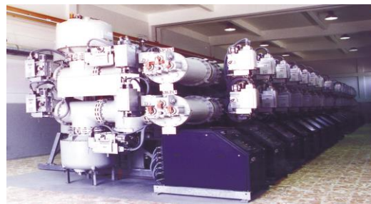
Figure I-7 : Poste isole dans le gaz [8]
