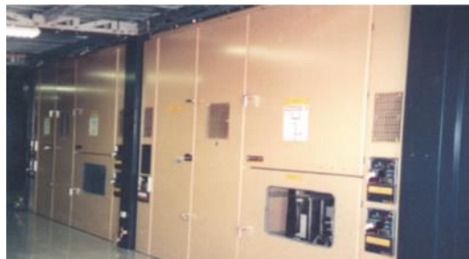
Figure I-8 : Poste isolé à l'air [8]
