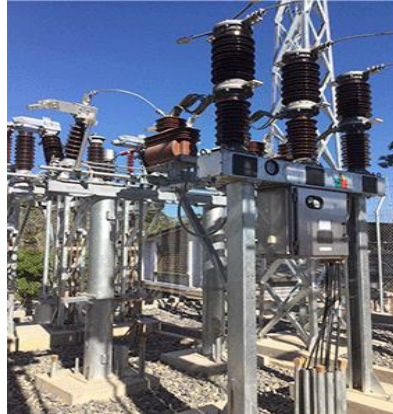
Figure II-14 : Disjoncteur à coupure sous vide de Live Tank 40,5 kV [26]
