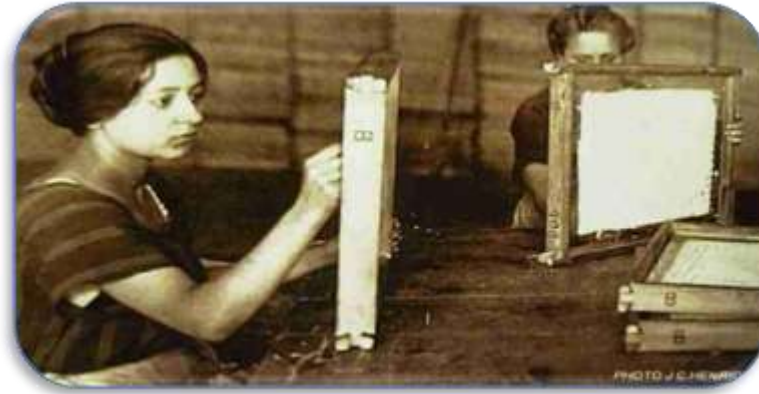
Figure 08 : Enfleurage manuel à froid utilisé au début du siècle (Anonyme, 1998)
