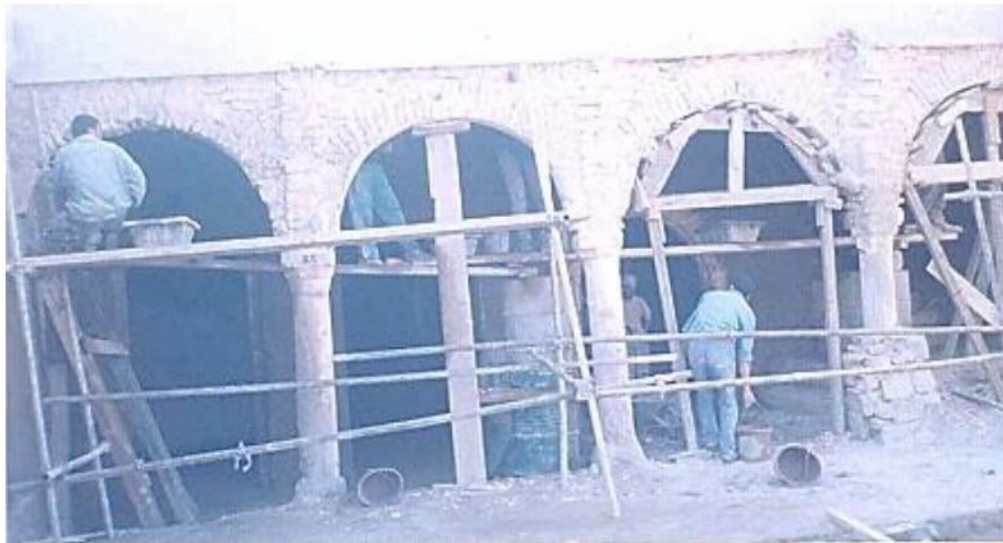
الصورة رقم (86) عقود حصن الترك قبل عملية الترميم مدينة مستغانم
