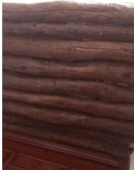
الصورة رقم (87) تقنية تسقيف لاحد ابواب حصن الترك مدينة مستغانم
