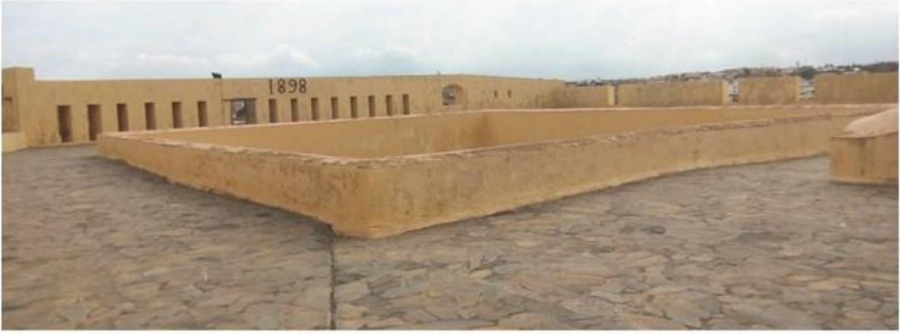
الصورة رقم (73) ممشى حصن الترك
