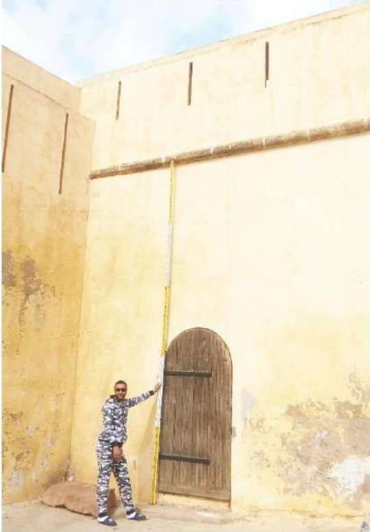
الصورة رقم: (51) المدخل الثانوي بـ رج الشمالي الشرقي لحصن الترك
