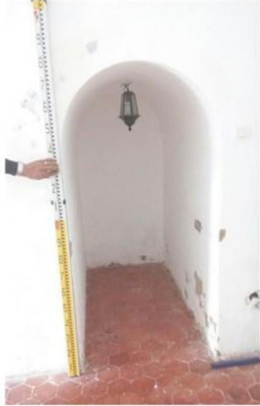
الصورة رقم: (68) فتحة تحت الدرج حصن الترك
