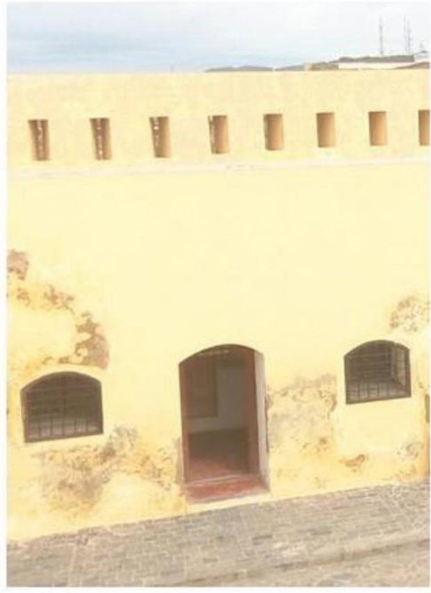
الصورة رقم: (63) باب مع نافذتين في الواجهة الداخلية الشمالية لحصن الترك
