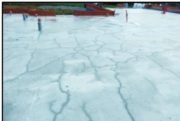
Figure I.12 : Retrait plastique dans un plancher
