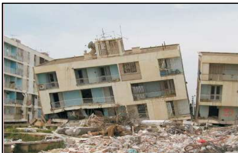
Figure VI.3 : Mauvaise conception structurale
