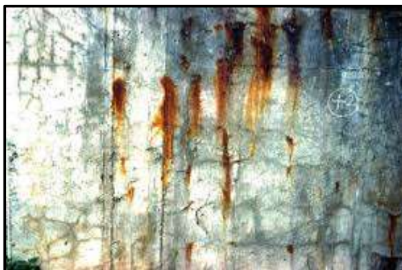
Figure I.8 : La corrosion dans le béton armé
