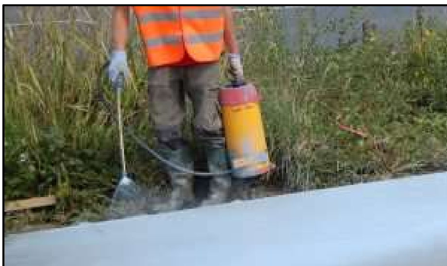
Figure I.13 : Pulvérisation après coulage
