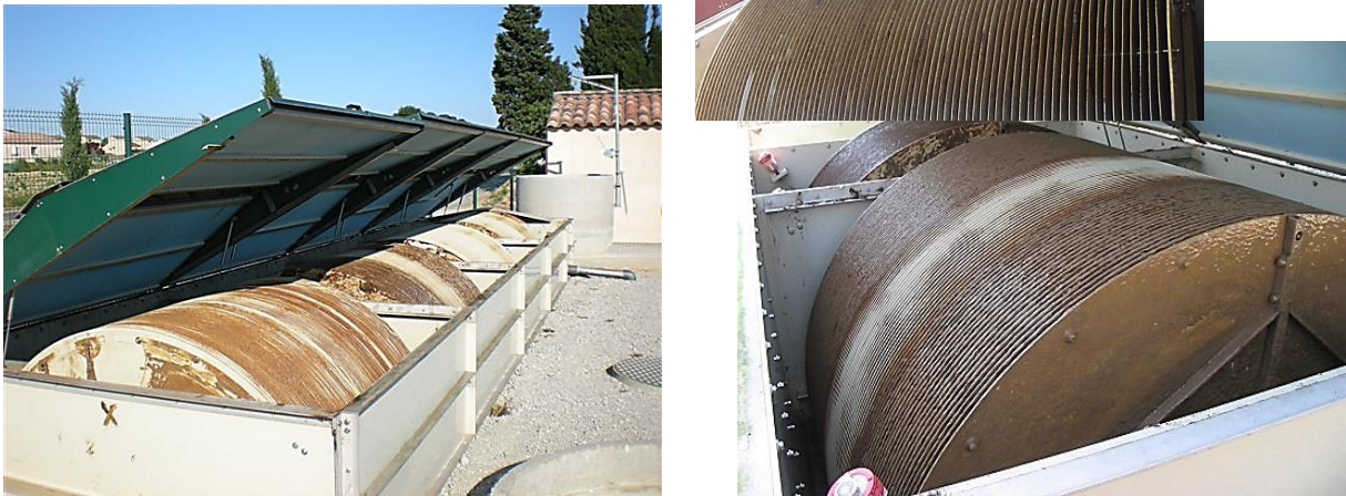
Figure 19 : Procédé d'épuration biologique par les disques biologiques.
