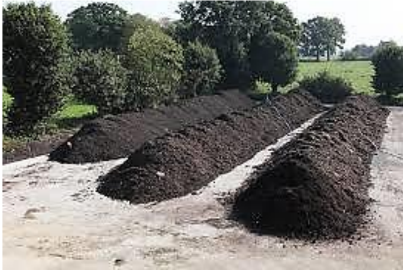
Figure 27 : Compostage d'un sol contaminé disposé en andains.
