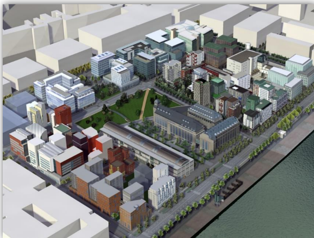
Figure 03 : Vue de l'ensemble du nouveau quartier de Masséna
