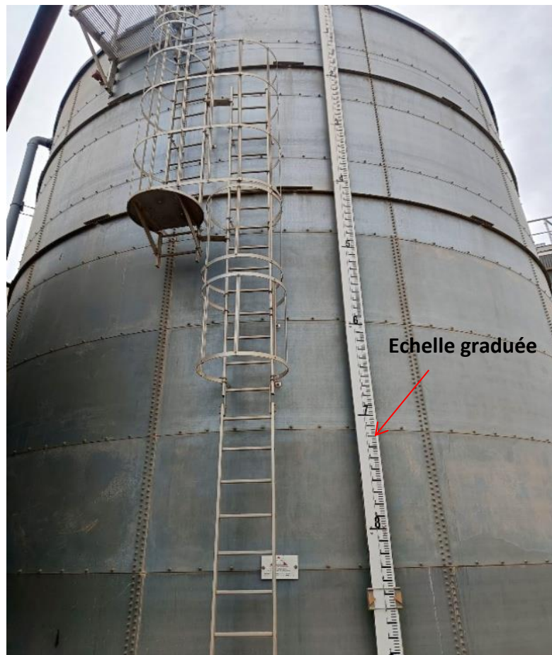
Figure 13 : Réservoir avec échelle graduée de lecture du niveau mesurer par un flotteur (SARL COFEED-Mohammedia).
