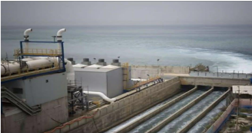
Figure I-9 : Système de captage de l'eau de mer.
