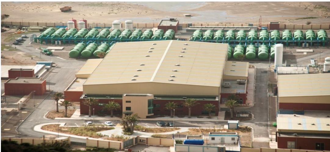
Figure I-6 : Station de dessalement de Sonactec (Mostaganem).
