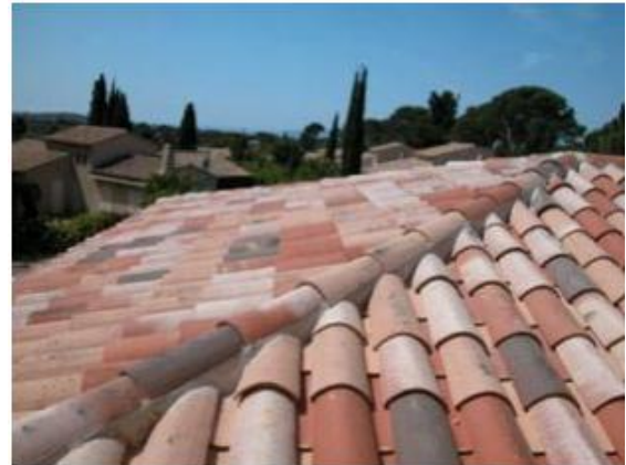
Photo17 : d'une toiture en terre cuite
