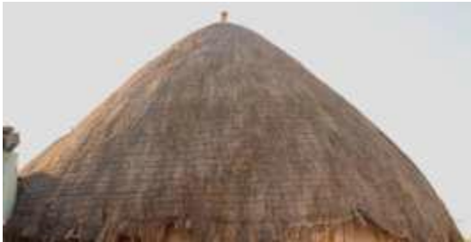
Photo16 de toiture de toitures de maison du kutch
