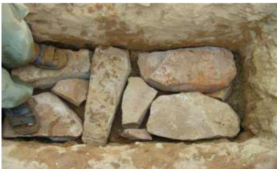
Photo 18 de l'élaboration du soubassement
