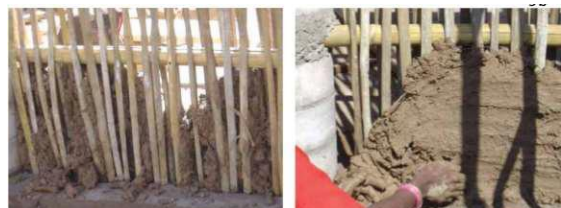
Photo20 du mur en torchis dans les bhungas
