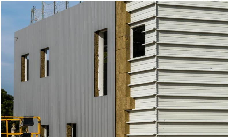
Photo 1 : Isolation extérieur d'un bâtiment industrielle 22
