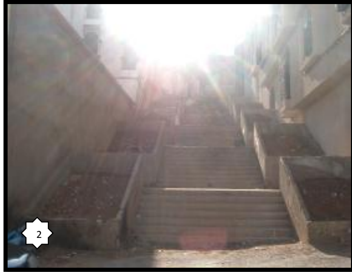
Photo24 de l'escalier reliant la partie haute et basse du quartier
