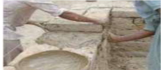
Photo 19 de la mise en œuvre de mur
