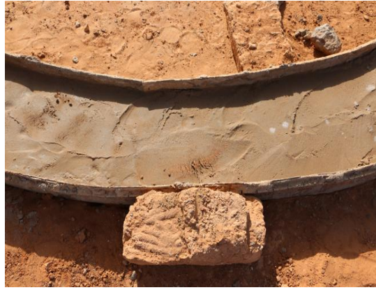
Photo 7 et 8 : de coulage de béton 7
