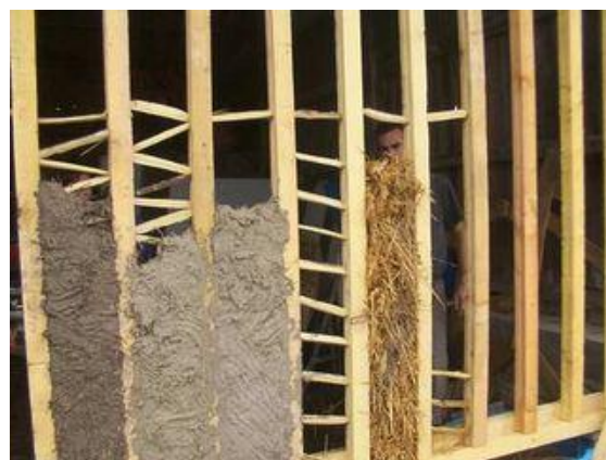
Photo 15 : de la mise en place du torchis 16
