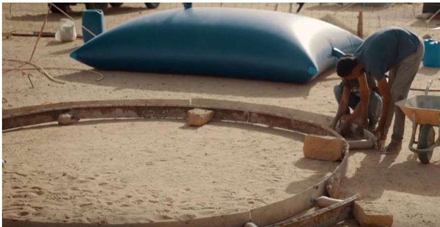
Photo 6 : du coffrage de lu soubassement en beton 6
