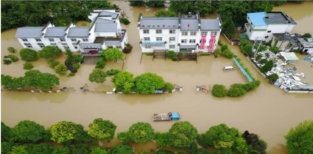
Figure I.2: Inondation par ruissellement en secteur urbain 7
