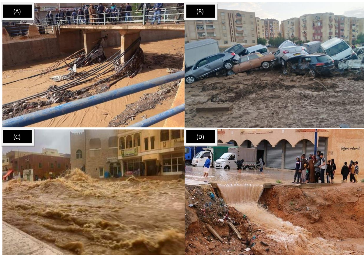
Figure III.6: Les inondations de 3 mai 2021 à Beni Slimane (Médéa) 22 (a) crue d'oued Boukraa; (b) voitures emportées par la crue; (c) inondation des routes; (d) effondrement partiel des routes
