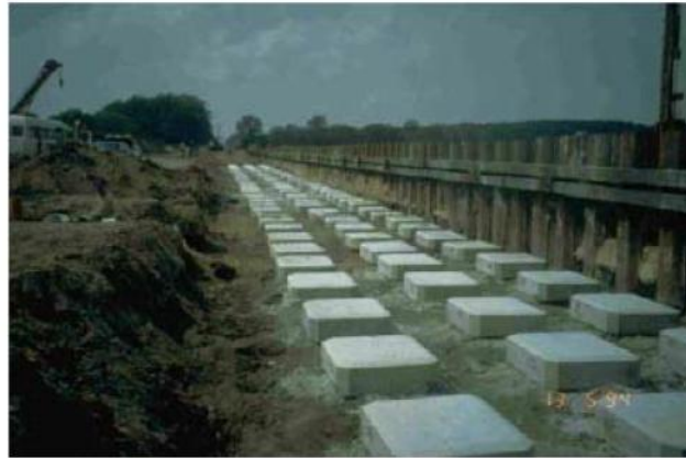
Fig III.14 Chantier de remblai ferroviaire, visualisation des têtes d'inclusion avant l'édification du remblai, d'après (Zanziger et Gartung, 2002)
