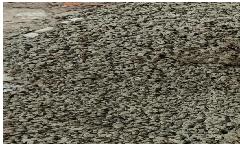
Figure 28-II: Réalisation du béton drainant témoin.
