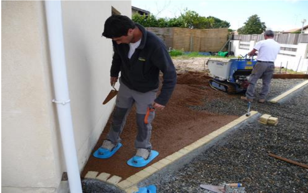
Figure 13-I: Damage du béton drainant
