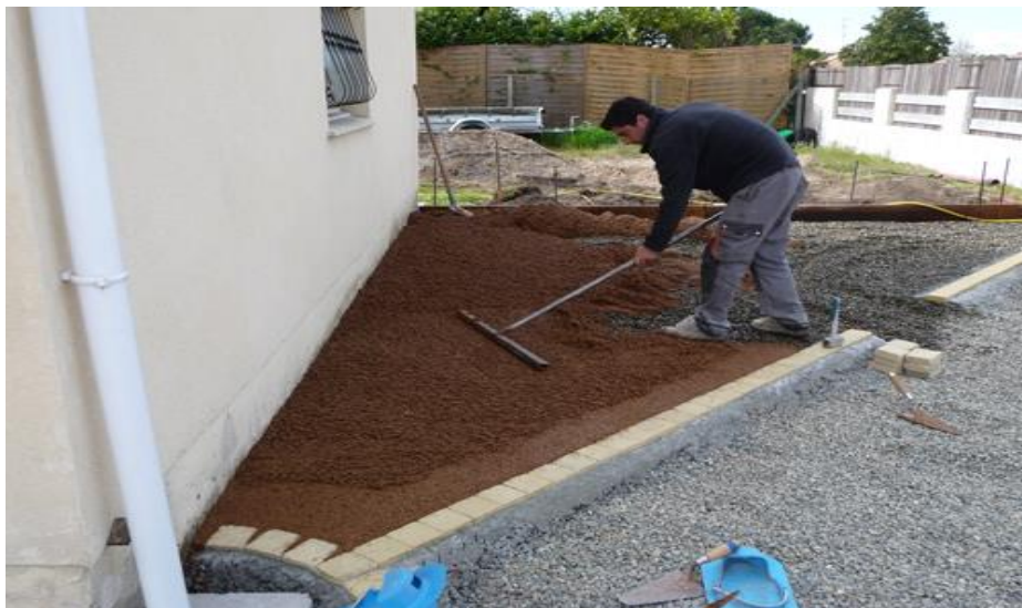
Figure 12-I: étalage du béton drainant
