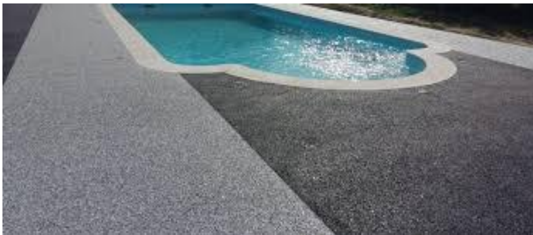
Figure 8-I: Autour d'une piscine en béton drainant
