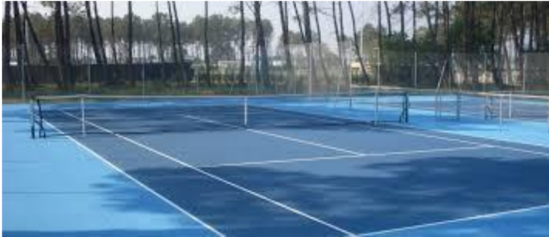
Figure 9-I: stade de tennis en béton drainant
