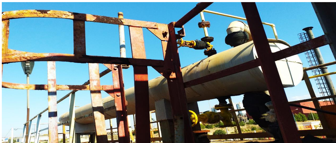
Figure I.24 : Echangeur de chaleur tubulaire à calendre HE-162.
