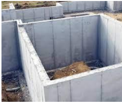
Figure 1. Mur voile en Béton Armée
