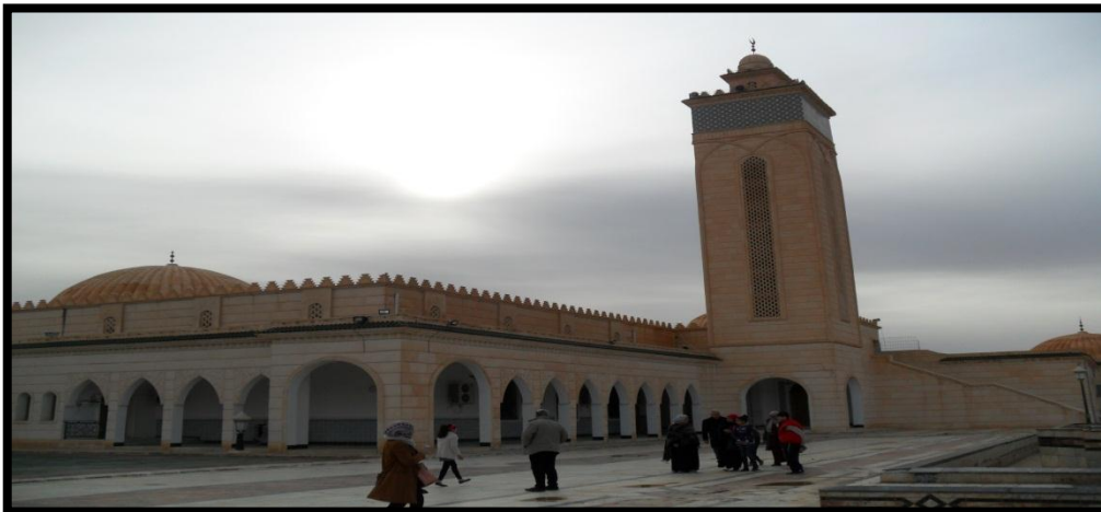
Figure 65 : Mosquée Okba Ibn Nafaa/ Source : Auteur.
