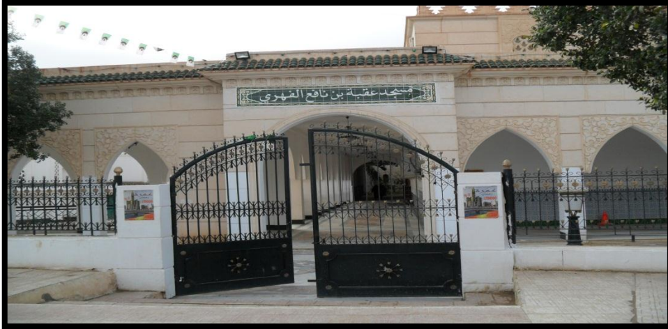
Figure 66 : Entré de la mosquée Okba ibn Nafiaa / Source : Auteur.
