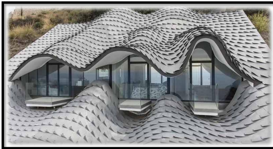
Figure 125 : la façade principale de la maison troglodyte.
