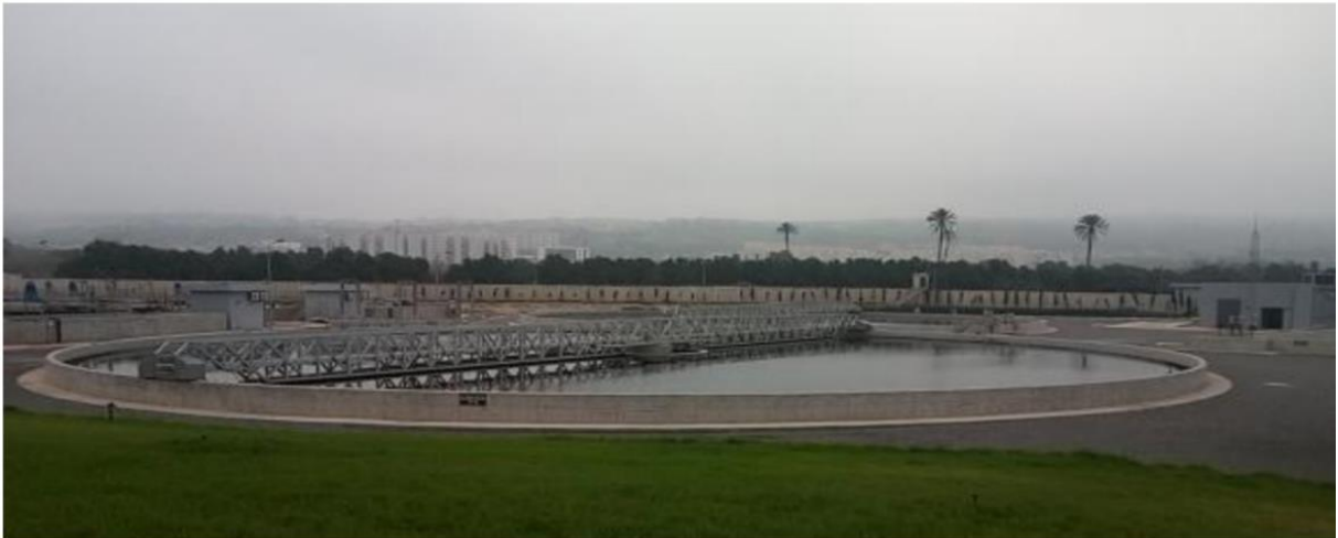
Figure 7. Décantation secondaire (photo prise à la station)
