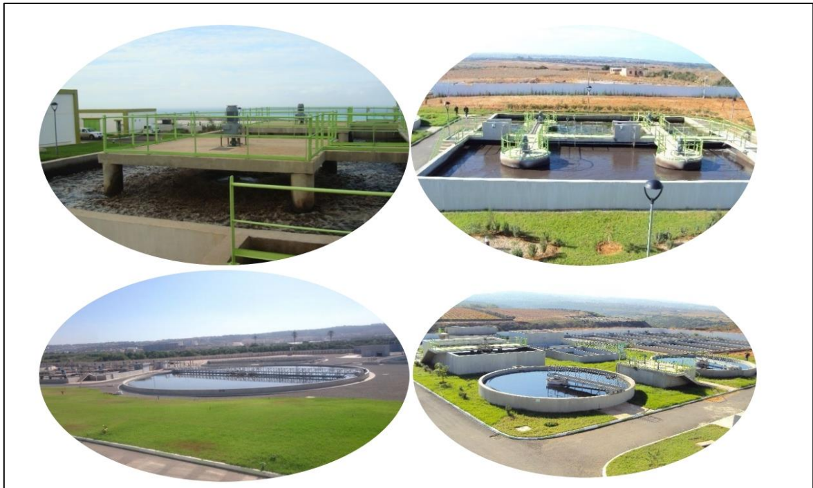
Figure 2. Vues sur les stations d'épuration STEP de Mostaganem
