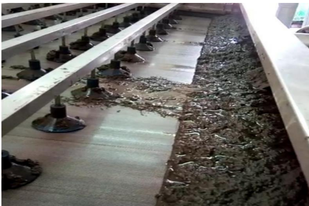
Figure 10. Épaississement (photo prise à la station)
