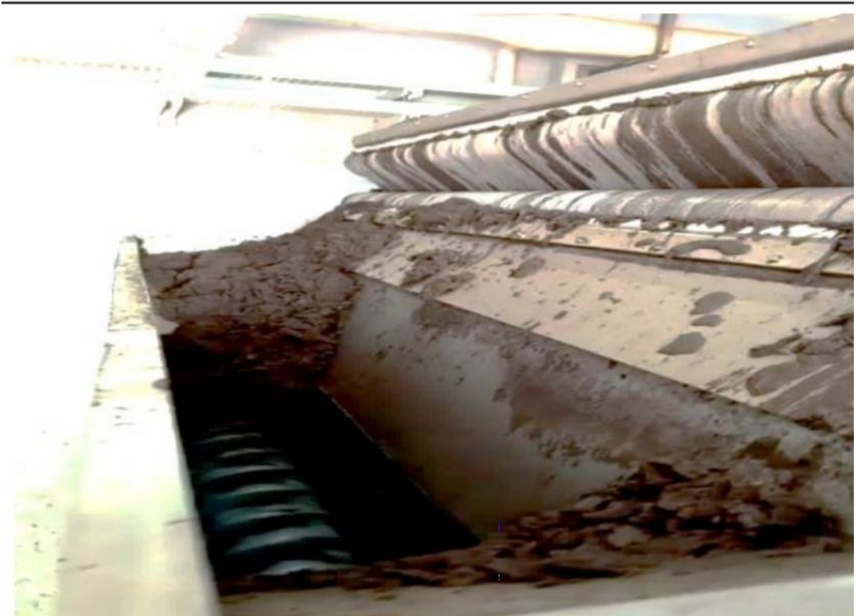
Figure 11. Le procédé filtre bande (photo prise à la station)
