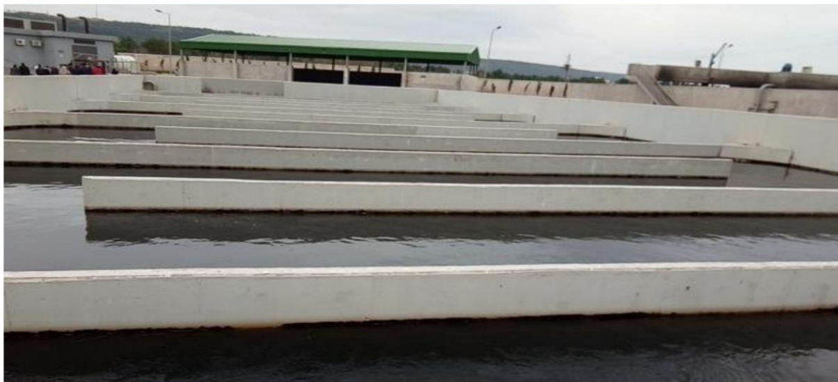
Figure 8. Désinfection (photo prise à la station)
