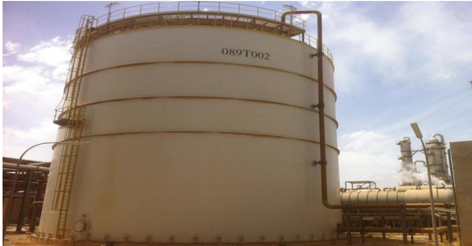
Figure I.3 : Photo de réservoir d'eau dessalée.
