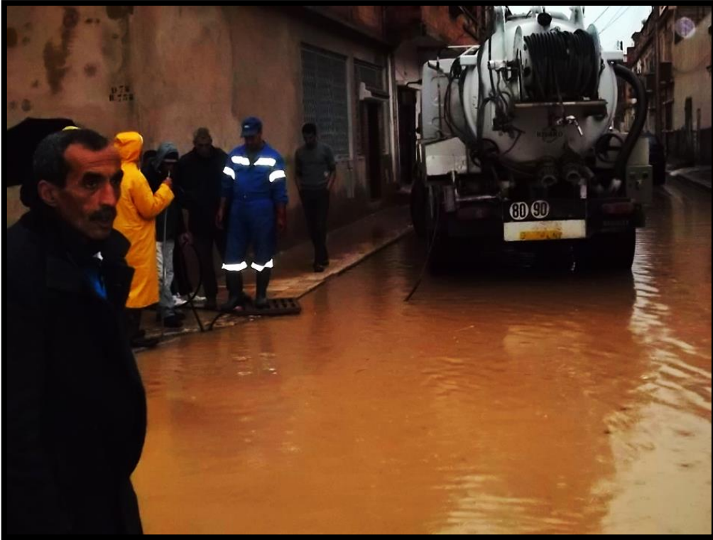
Figure 2.9. LA STAGNATION DES EAUX PLUVIALES DANS LE QUARTIER DE AISSAT IDIR
