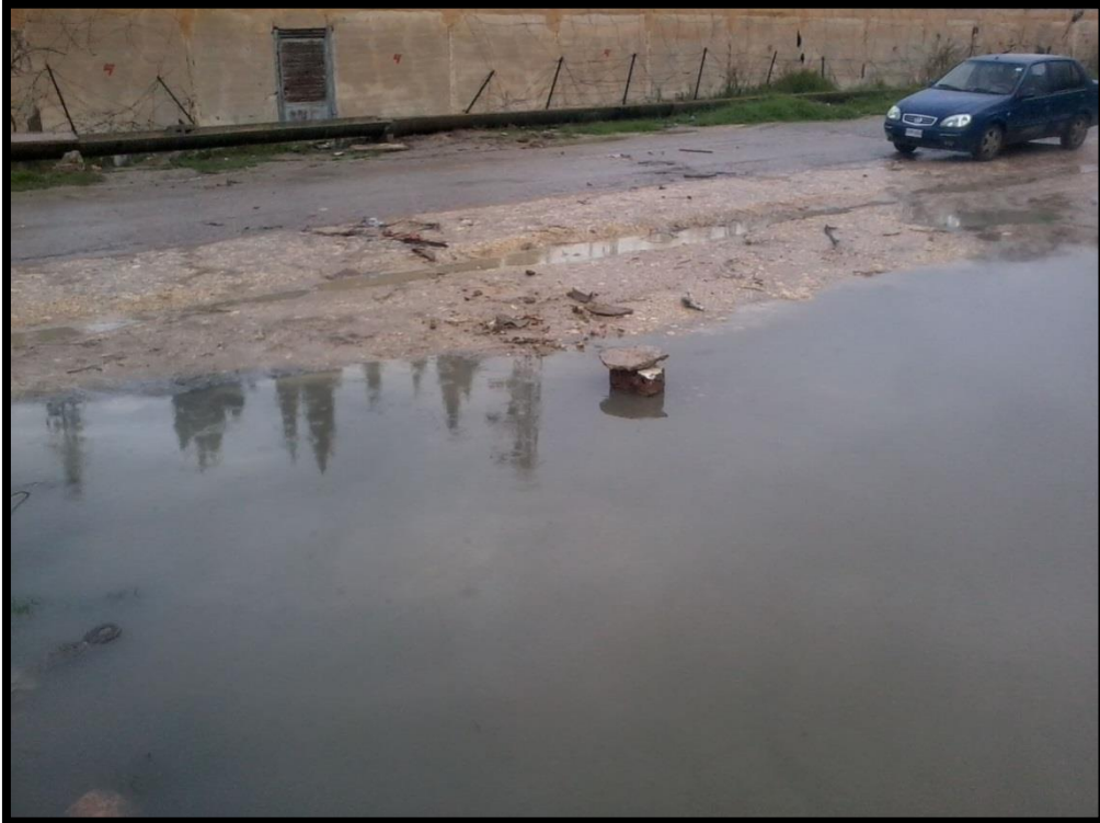
Figure 2.10. LA STAGNATION DES EAUX PLUVIALES DANS LE QUARTIER DE BECHMIRIK
