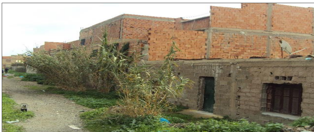
Figure 2.18. VUE SUR LES QUARTIERS RÉSIDENIELS PRÉCAIRE 'RACK'.
