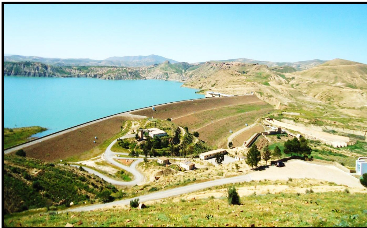
-VUE SUR LE BARRAGE DE SIDI MHAMED BEN AOUDA-
