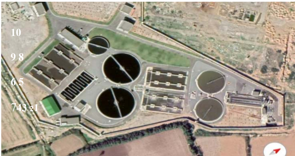
Figure I.3. Les installations de la STEP salamandre, La ville de Mostaganem.
