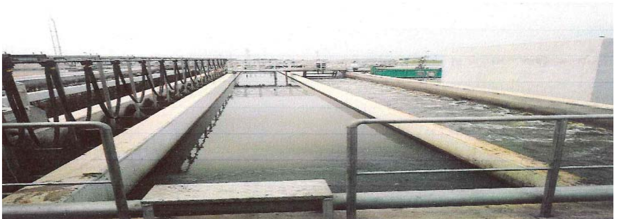
Figure I.6. Pont dessableur/déshuileur.
