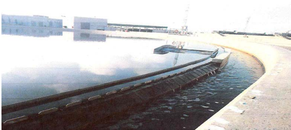
Figure I.9. Clarificateur (décantation secondaire).
