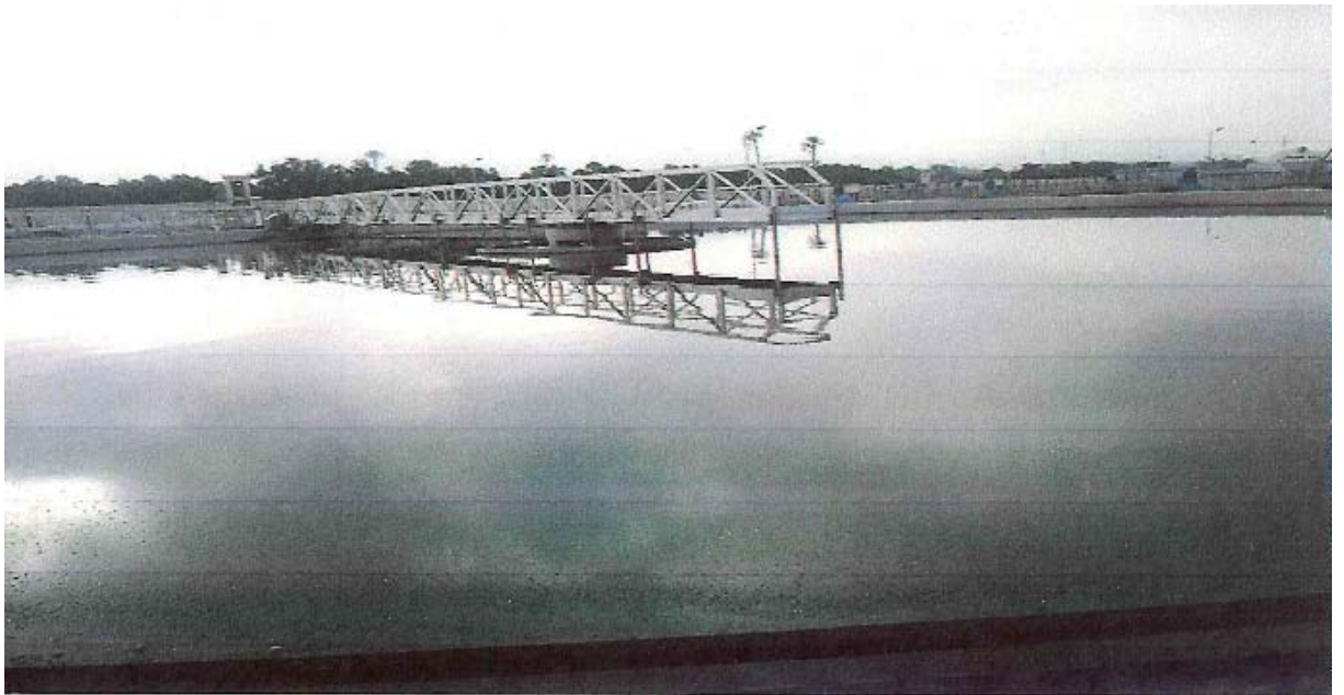
Figure I.7. bassin décantation primaire.
