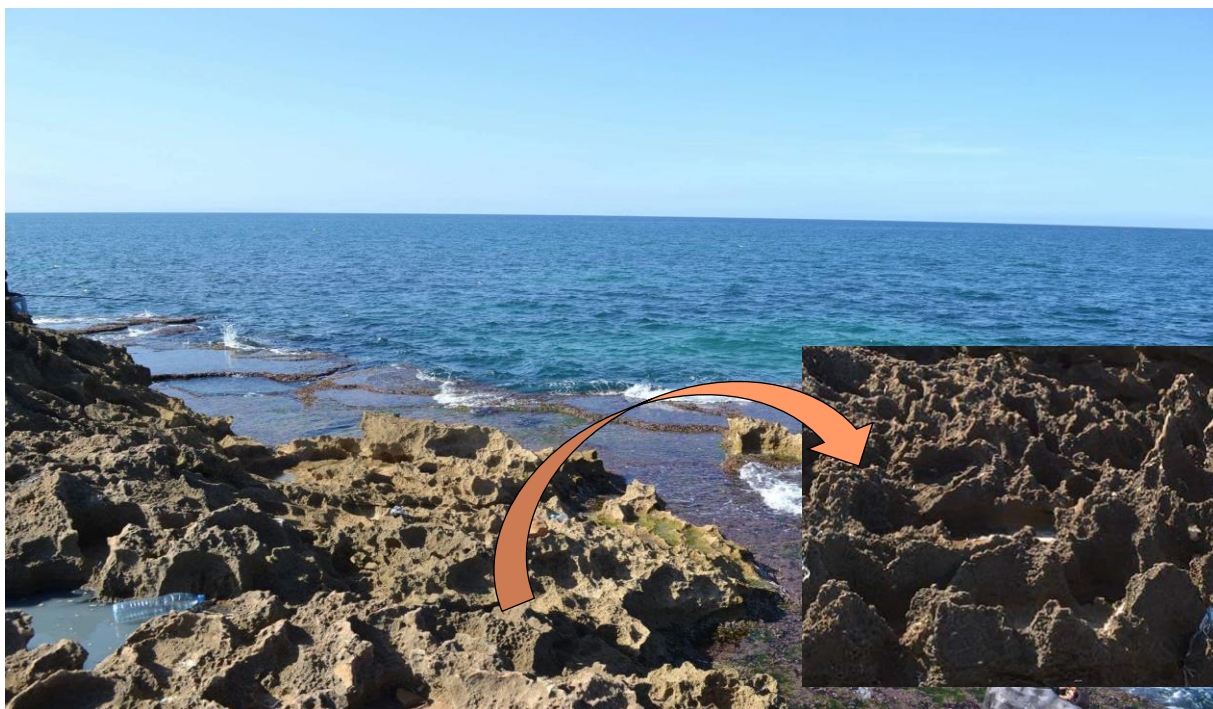
Figure 194: photo de constat Source Auteur 2019
