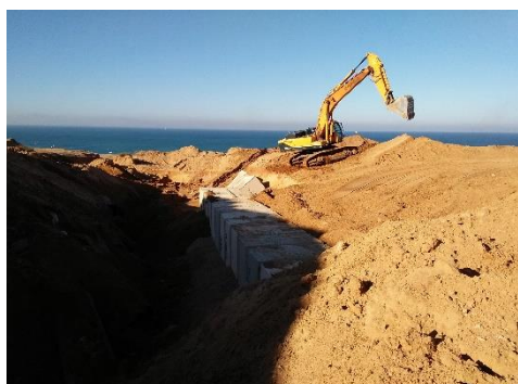
Figure159:les dalots Source :direction de l'hydrolique
