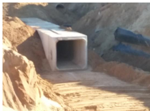
Figure161:les dalots Source :direction de l'hydrolique
