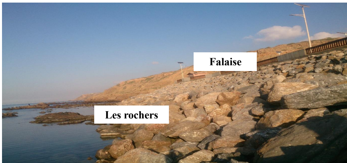
Figure189 : photo de constat Source Auteur 2019
