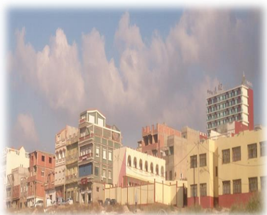
Figure206 :habitat individuelle Source: Auteur2019
