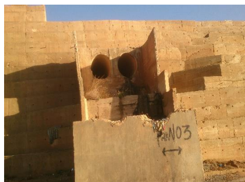
Figure163:les dalots Source :direction de l'hydrolique
