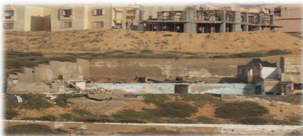
Figure 6 : façade urbaine amoché Source :Auteur 2019
