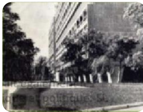
Figure 10: Figure : photo de période, l'espace urbain était négligé Source:web2019
