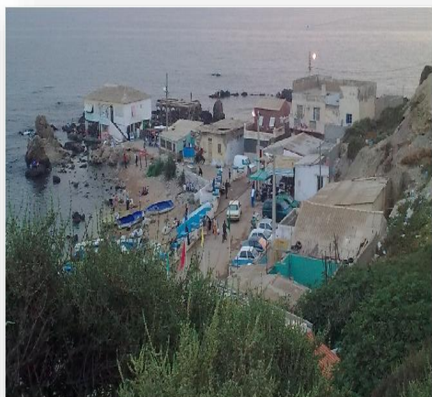
Figure141:photo d'une habitation achevée
