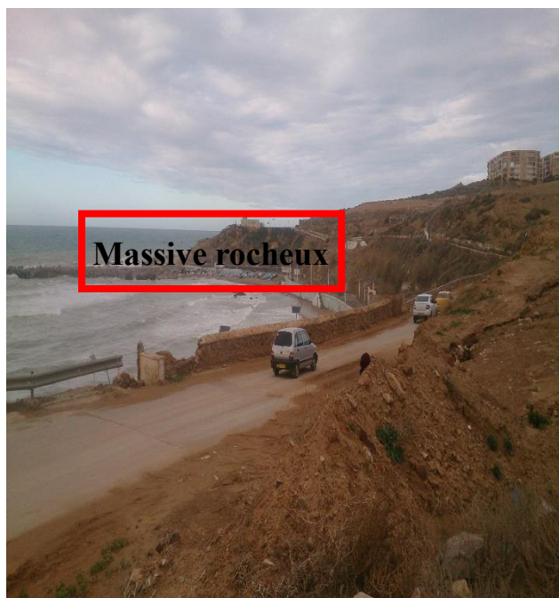
Figure185: photo de constat Source Auteur 2019
