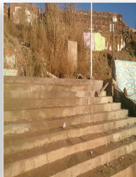
Figure150:l'escalier du site Source Auteur
