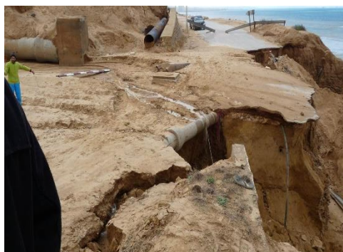
Figure160:les les eaux pluviales du chaabat Source :direction de l'hydrolique
