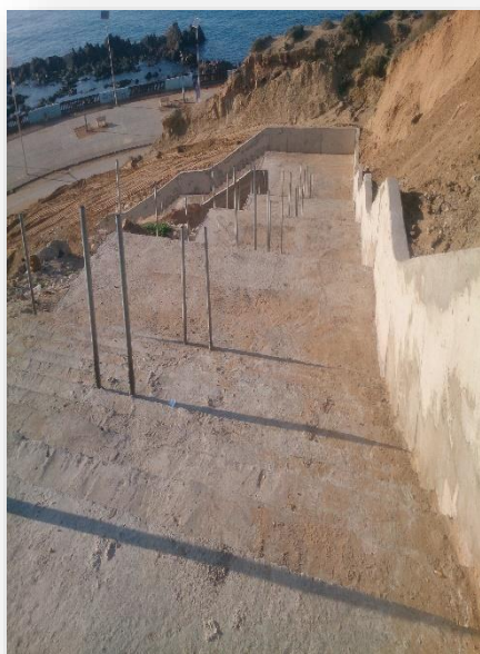
Figure148:l'escalier du site Source Auteur
