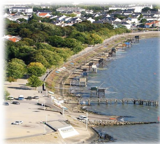
Figure83 : photo de projet saint –Nazaire Source:Archidaily
