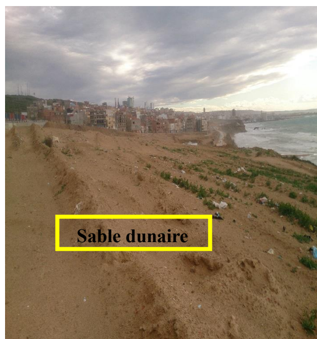
Figure188: photo de constat Source Auteur 2019
