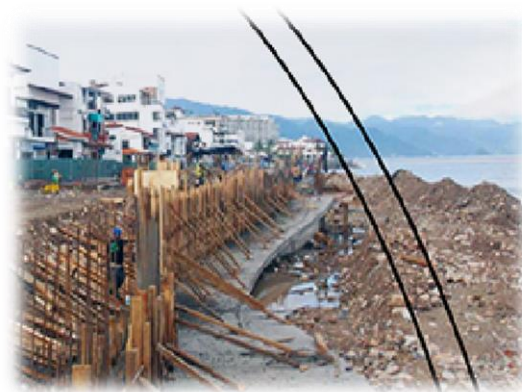
Figure49:le mur de soutènement en cours de réalisation Source:Archidaily
