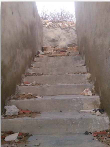
Figure149:l'escalier du site Source Auteur
