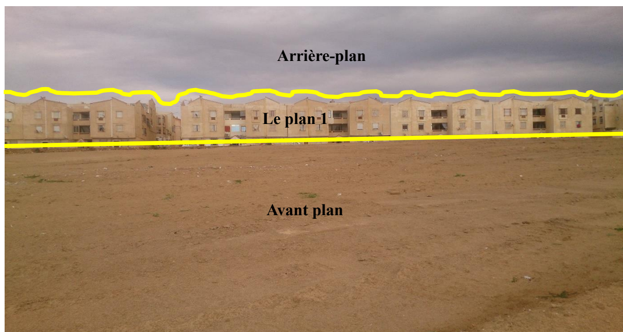
Figure184 : photo de constat Source Auteur 2019
