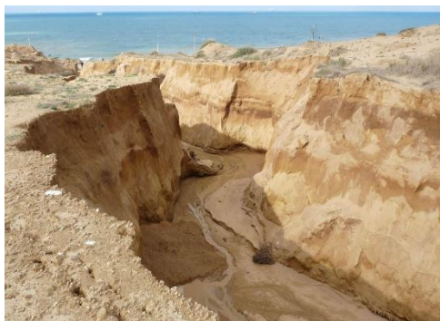
Figure158:les les eaux pluviales du chaabat Source :direction de l'hydrolique
