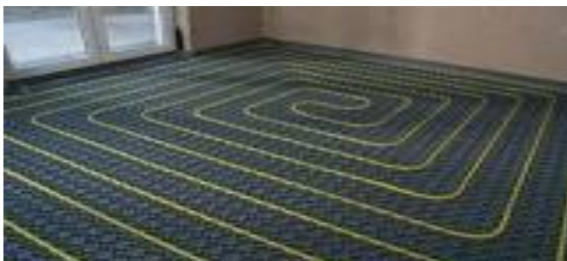
Figure I.6 : L'installation d'un plancher chauffant à eau
