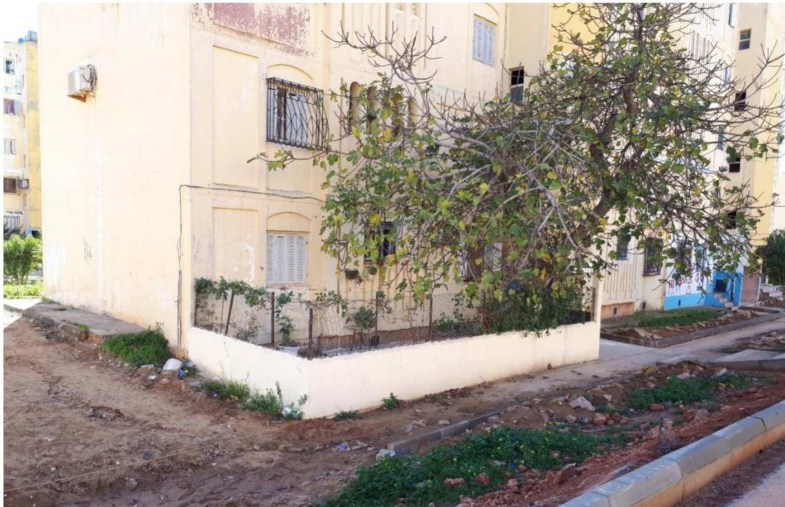
Figure 73: Un espace extérieur jardiné, cas des ZHUN cité 5 juillet à Mostaganem
