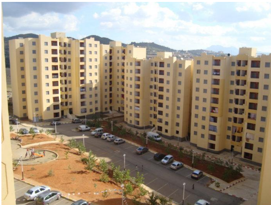
Figure 82 : de logements AADL à Boumerdes - Source : eldjazair365.com
