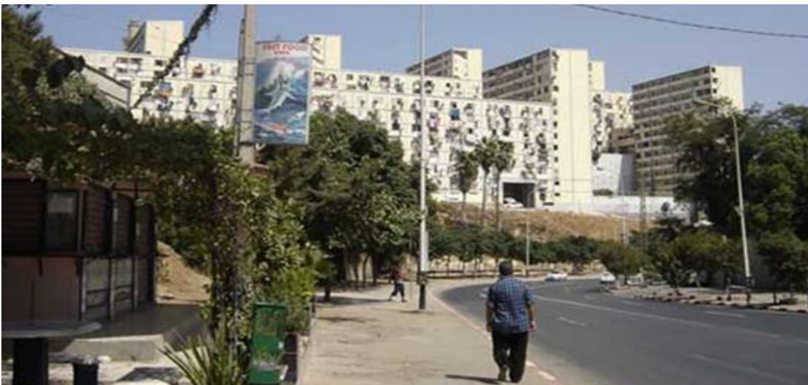
Figure 53 : La cité Diar Es Chams, Alger. - Source :Babel Med, Des vies de bric et de broc.
