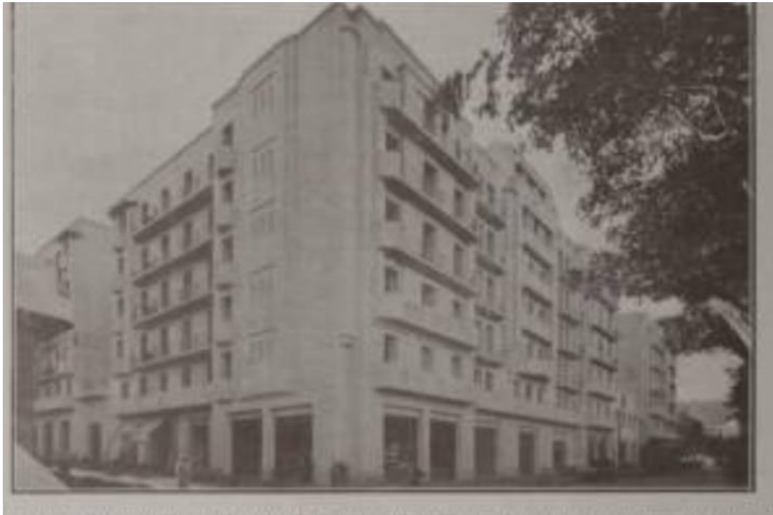
Figure 32: Les HBM du champ de Manoeuvre Alger - Source : (www.panoramio.com, www.gallica.bnf.fr, consultés le 5 mai 2014)
