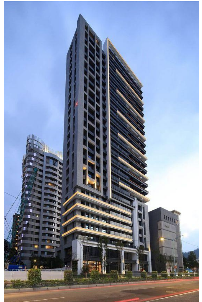
Immeuble résidentiel à Montréal ; CANADA
