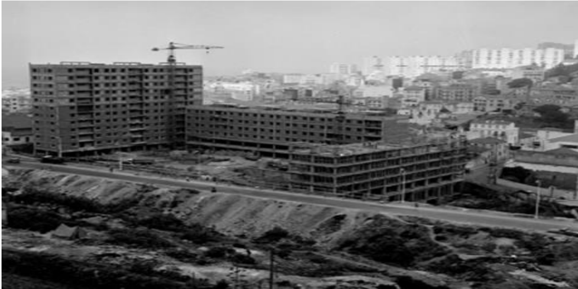
Figure 46 : Première tranche des travaux à Diar El-Keff dans un quartier périphérique d'Alger, dans le cadre du plan de Constantine. Juillet 1959. - Source : L'application du plan de Constantine à Alger ECPAD
