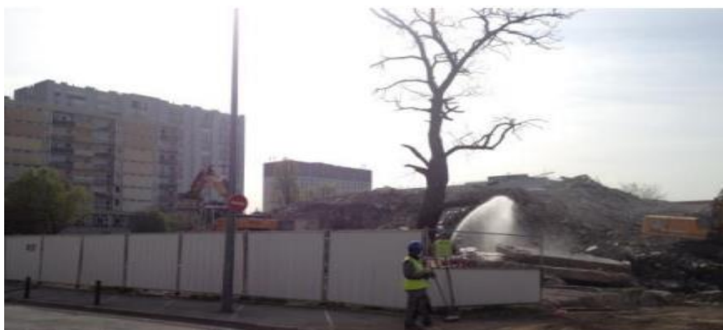
Figure 8 Immeuble démoli récemment au cœur du quartier - Source: Photo prise par Kenan Jundoosing, mars 2014
