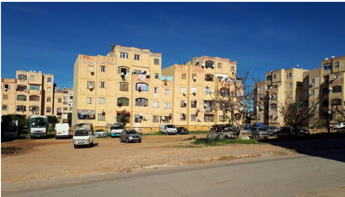
Figure 72: Des espaces extérieurs mal exploités, cas des ZHUN cité 5 juillet à Mostaganem
