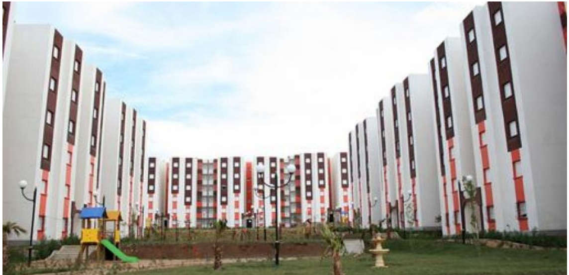
Figure 84 : Exemple d'un logement LPA ex LSP à Oran - Source : Internet
