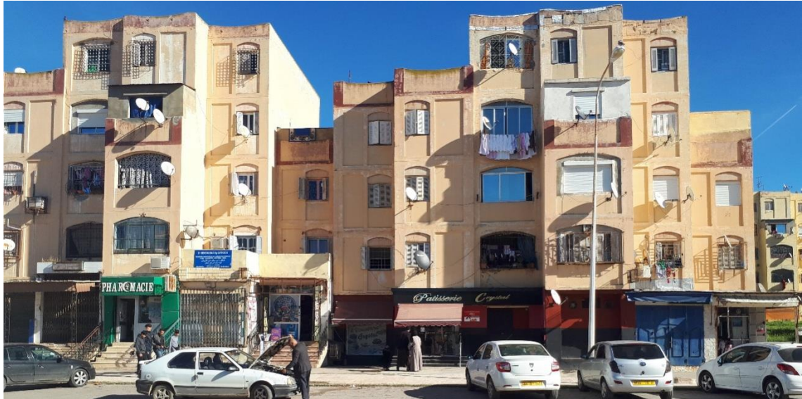
Figure 71: Exemple des façades d'une ZHUN à Mostaganem, cas la cité 5 juillet. Source : Auteur
