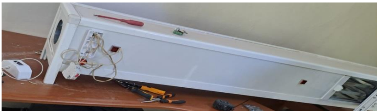
Figure III.19: Installation du circuit de puissance
