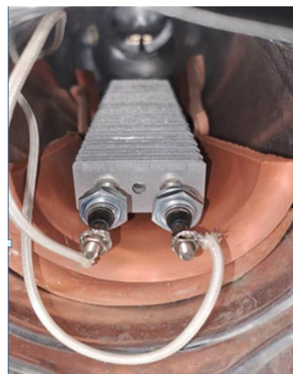
Figure III.14. Résistance électrique chauffante à ailette et son emplacement dans le circuit aéraulique
