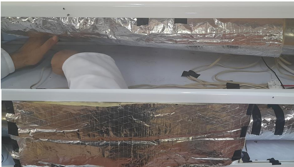
Figure III.12 . Installation de la laine de verre sur le séchoir
