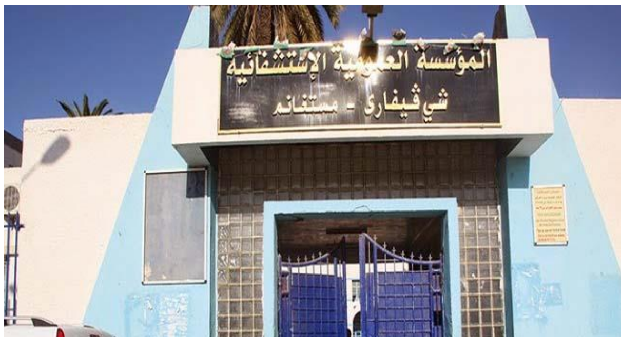
Figure 22 : Vue de la face de l'établissement public hospitalier -Chéguévara-Mostaganem.
