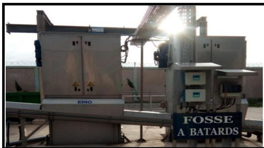
Figure II.4 Dégrilleur grossier
