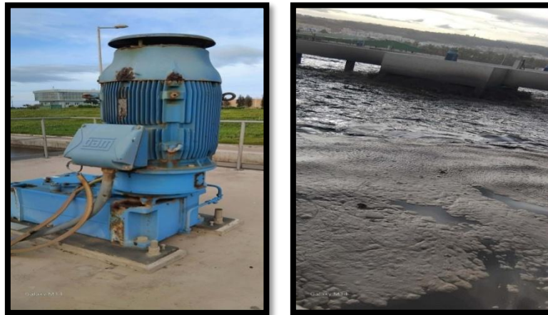
Figure II.7 Bassin biologique (bassin d'aération)
