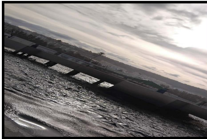
Figure II.10 Bassin de stabilisation
