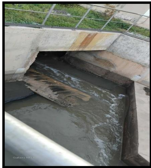
Figure II.3 Déversoir d'orage
