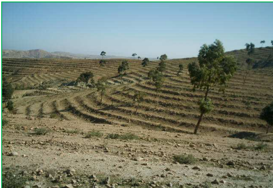
Planche 6: Travaux d'aménagement des terrasses (Original: mai, 2010)
