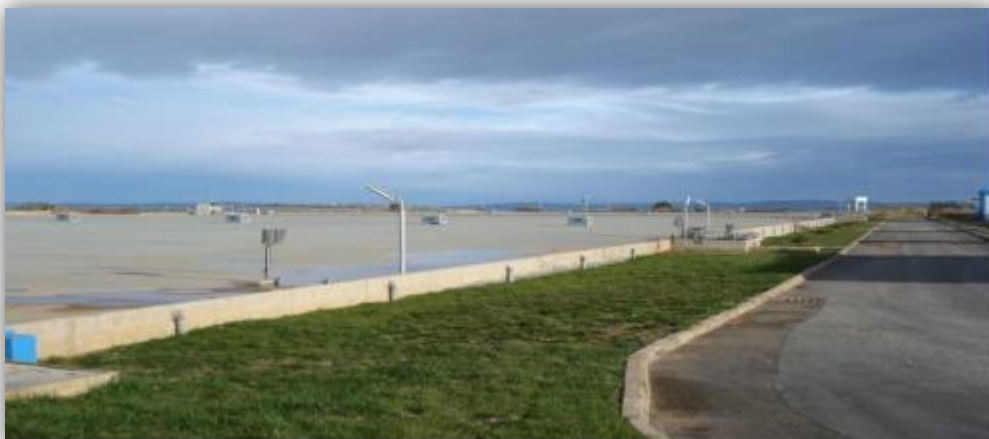
Figure. III. 14 Réservoir de stockage
