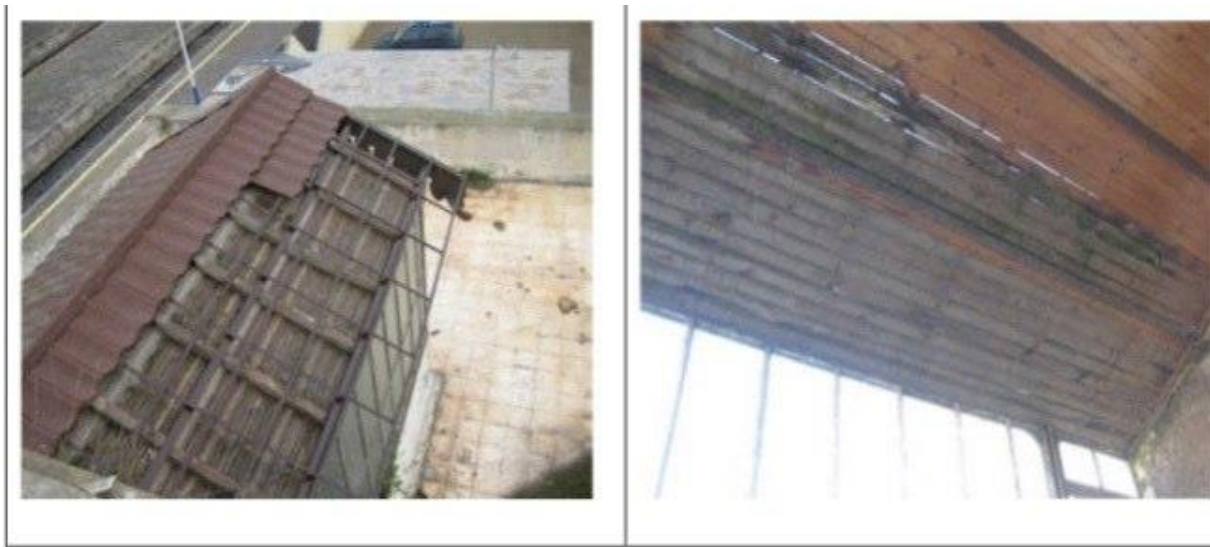
figure 42 : réparation de la toiture
