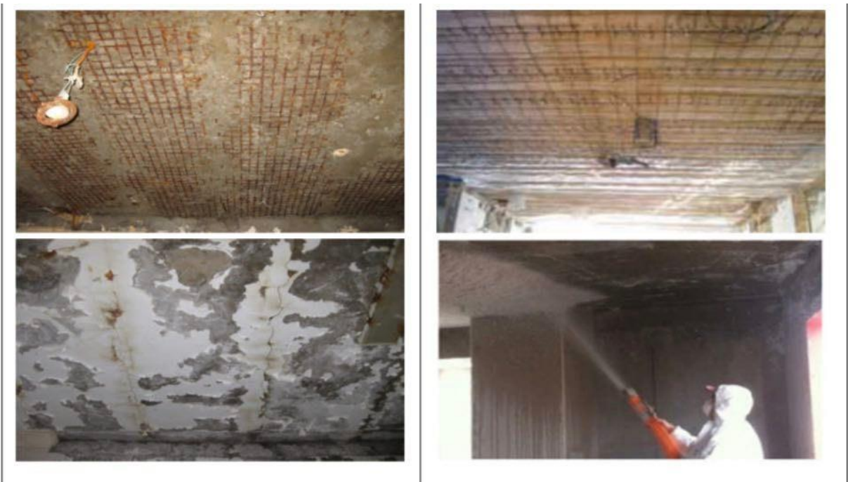
figure38 : enduits de renfort ( treillis métalliques ).
