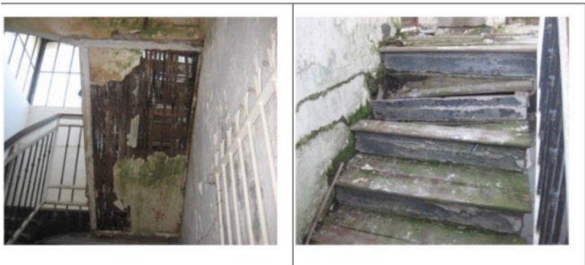
figure 43 : changement des escaliers
