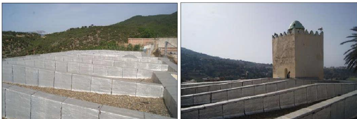
Figure 29 :- Vus de toiture de la mosquée.
