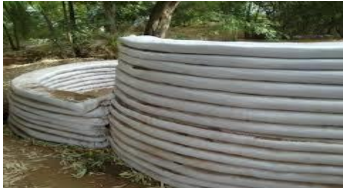
Figure III.4: Des murs en ecodome
