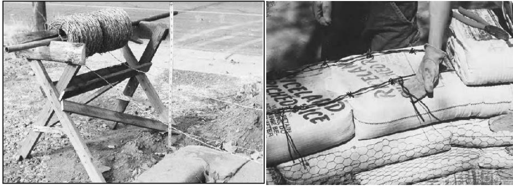
Figure II.6 : fixation du fil de fer barbelé.
