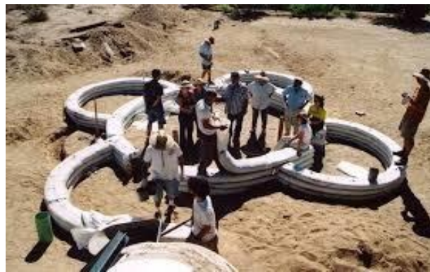
Figure III.7: Remplissage des sacs
