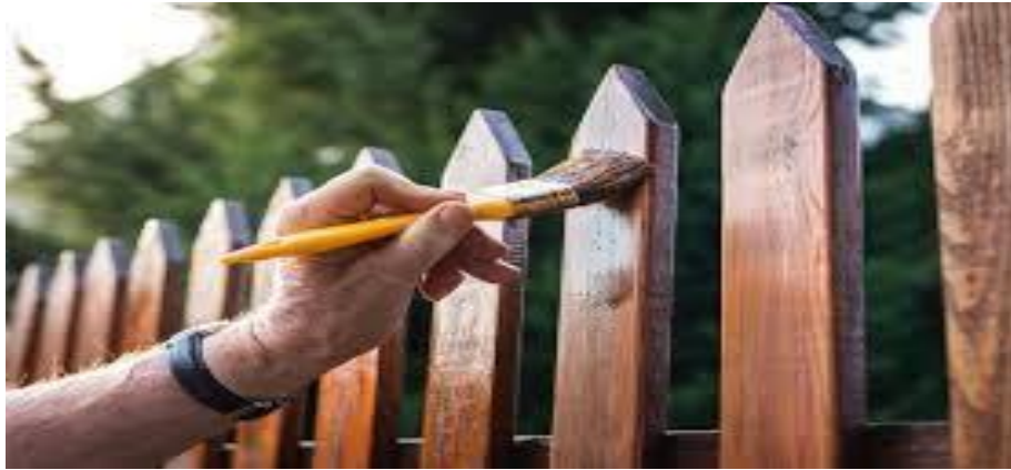
Figure IV.13 : Application de revêtements de finition
