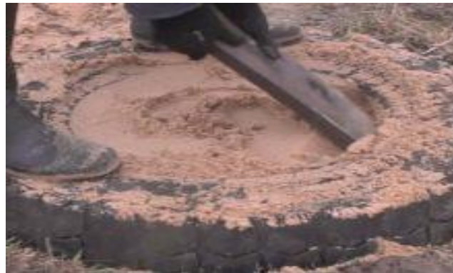
Figure III.15: Remplissage Des Pneus
