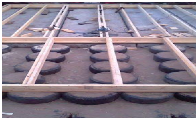
Figure III.12 : Fondation en Pneus
