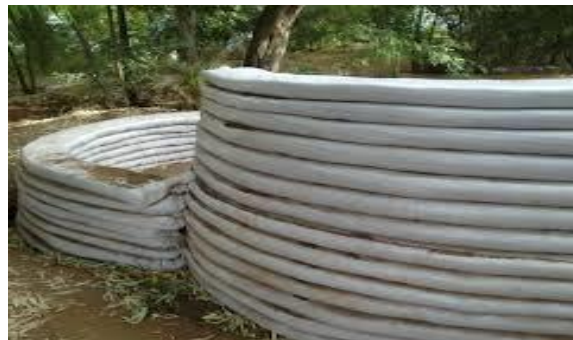
Figure II.5: Mise en place des sacs sous forme de rouleau
