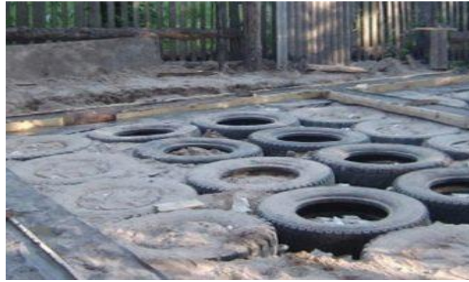
Figure III.13: Fondation en Pneus
