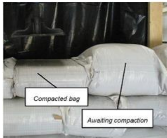
Figure II.4 : Compaction de sacs de terre pour structure de mur comprimée (Ross et al., 2013).
