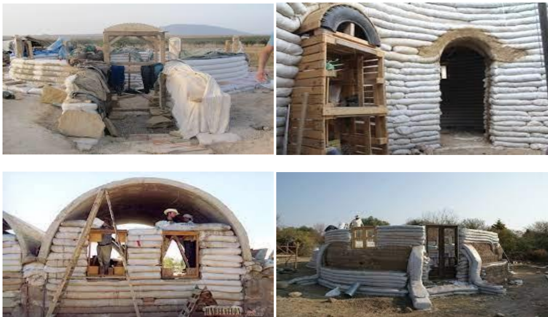
Figure II.7 : Les ouvertures de l'ecodome
