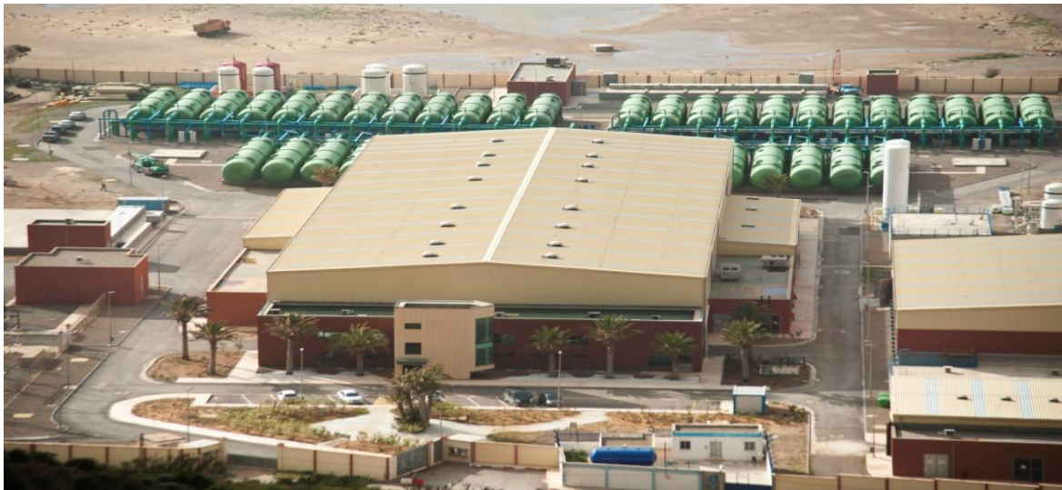
Figure II.A.2 : La station de dessalement de l'eau de mer de Mostaganem.
