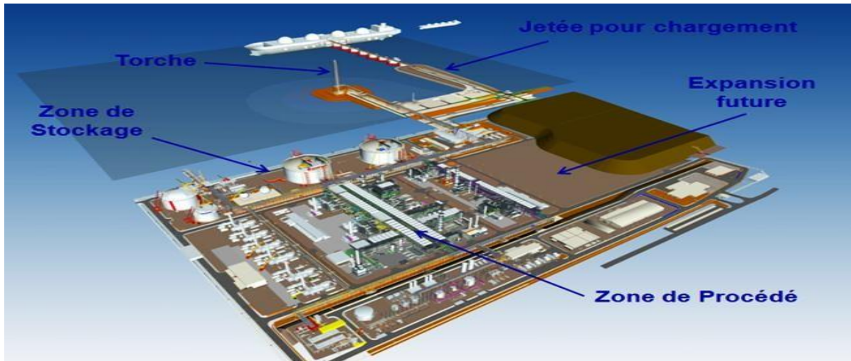
Figure I.2 : Vue générale du complexe GL3/Z
