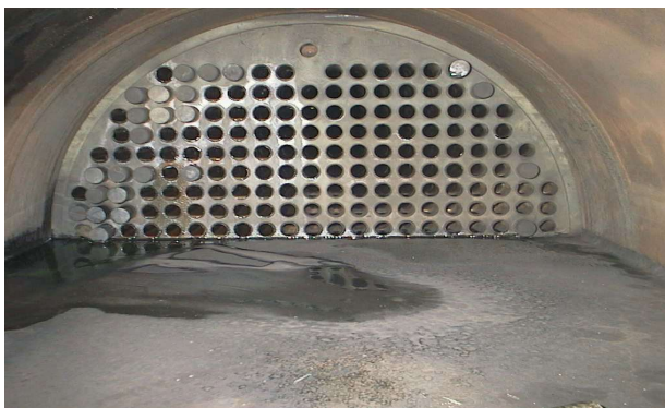
Figure III. 11 Elimination des tube à l'intérieur de E-520
