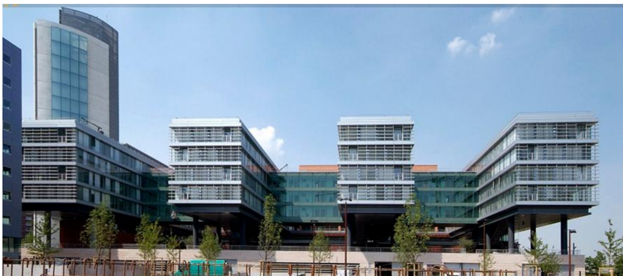
Figure 72 : façade principale du projet
