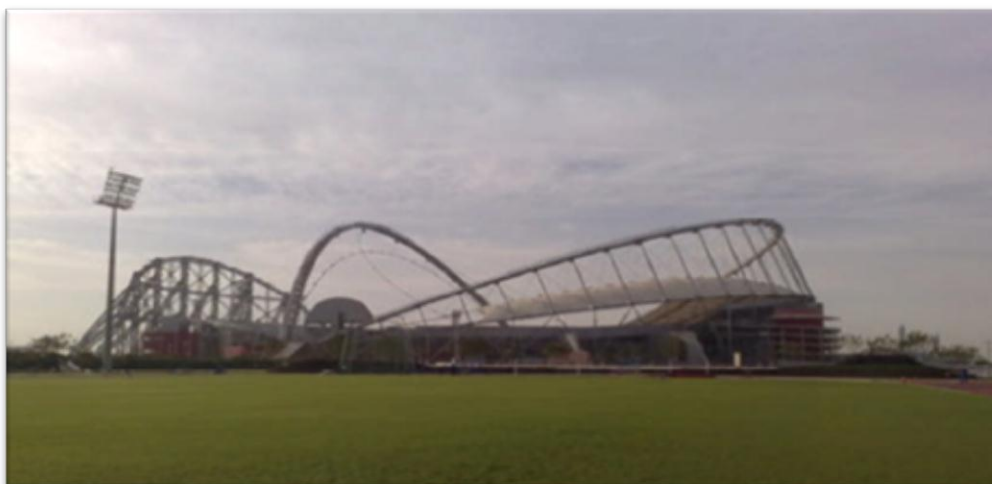
Figure 87 : vue générale sur le stade
