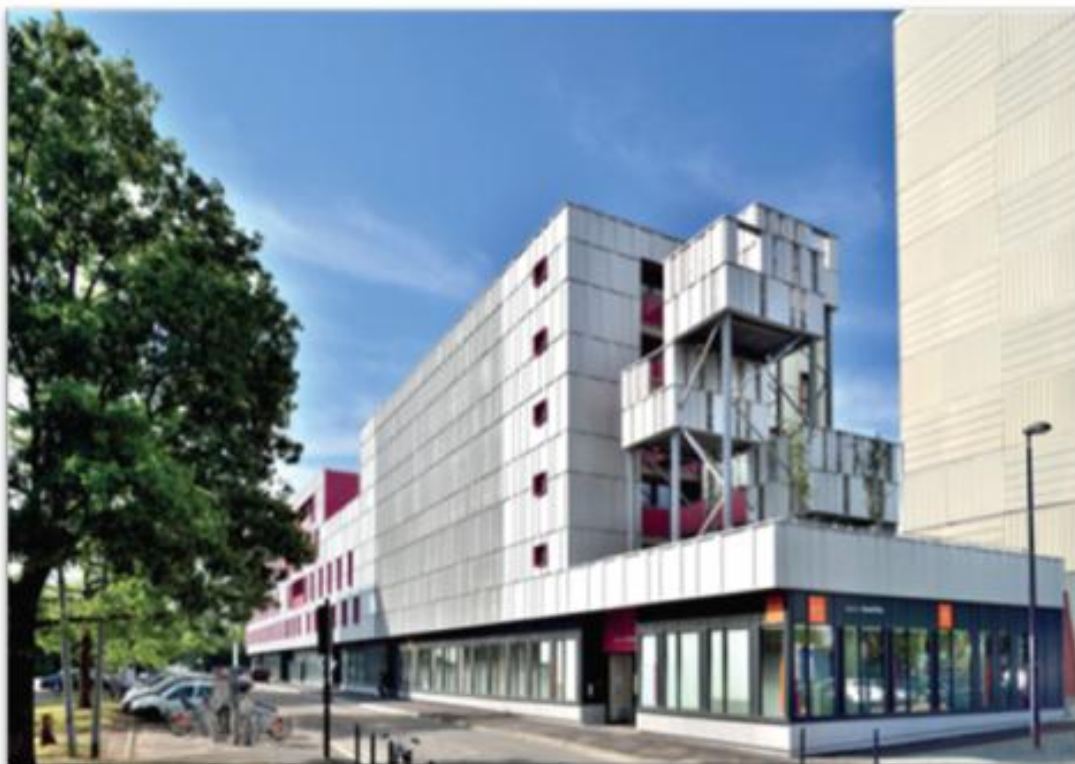
Figure 75 : façade latérale de groupement d'habitation en aquitanis
