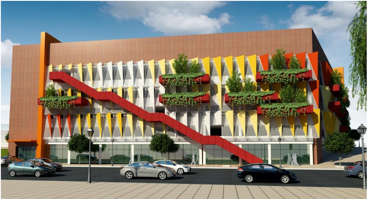
Figure 114 : parking a étage
