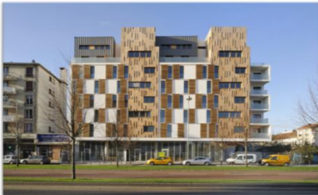
Figure 77 : façade principale de pole résidentielle de vutry
