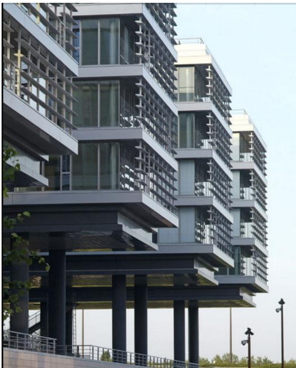
Figure 73 : détail de la façade principale
