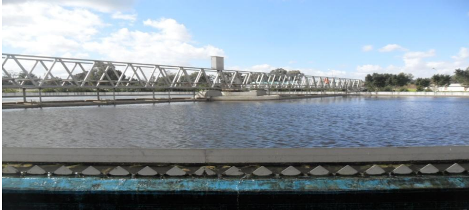
Figure II. 5 : bassin de clarificateur (ONA, 2019)
