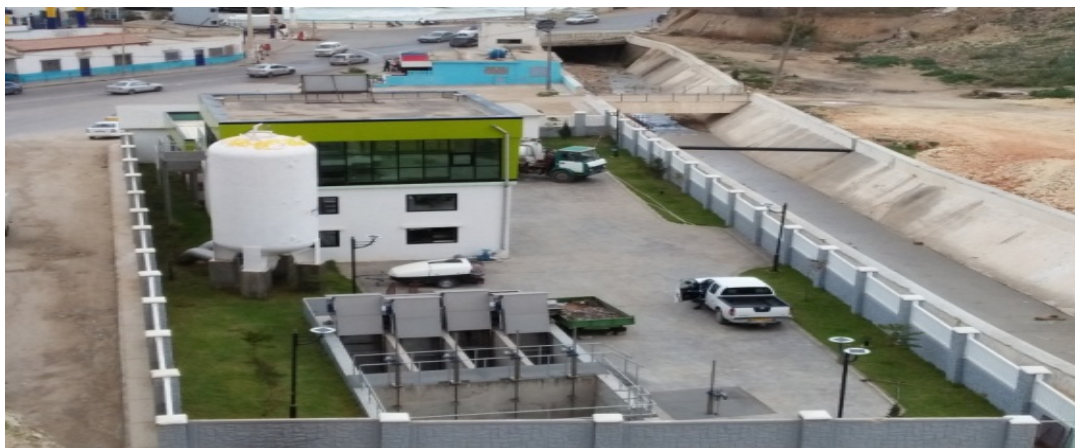
Figure 12 : Station de relevage de Ain Sefra
