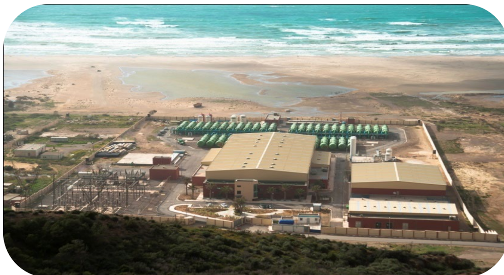
Figure 7 : Station de dessalement de Mostaganem
