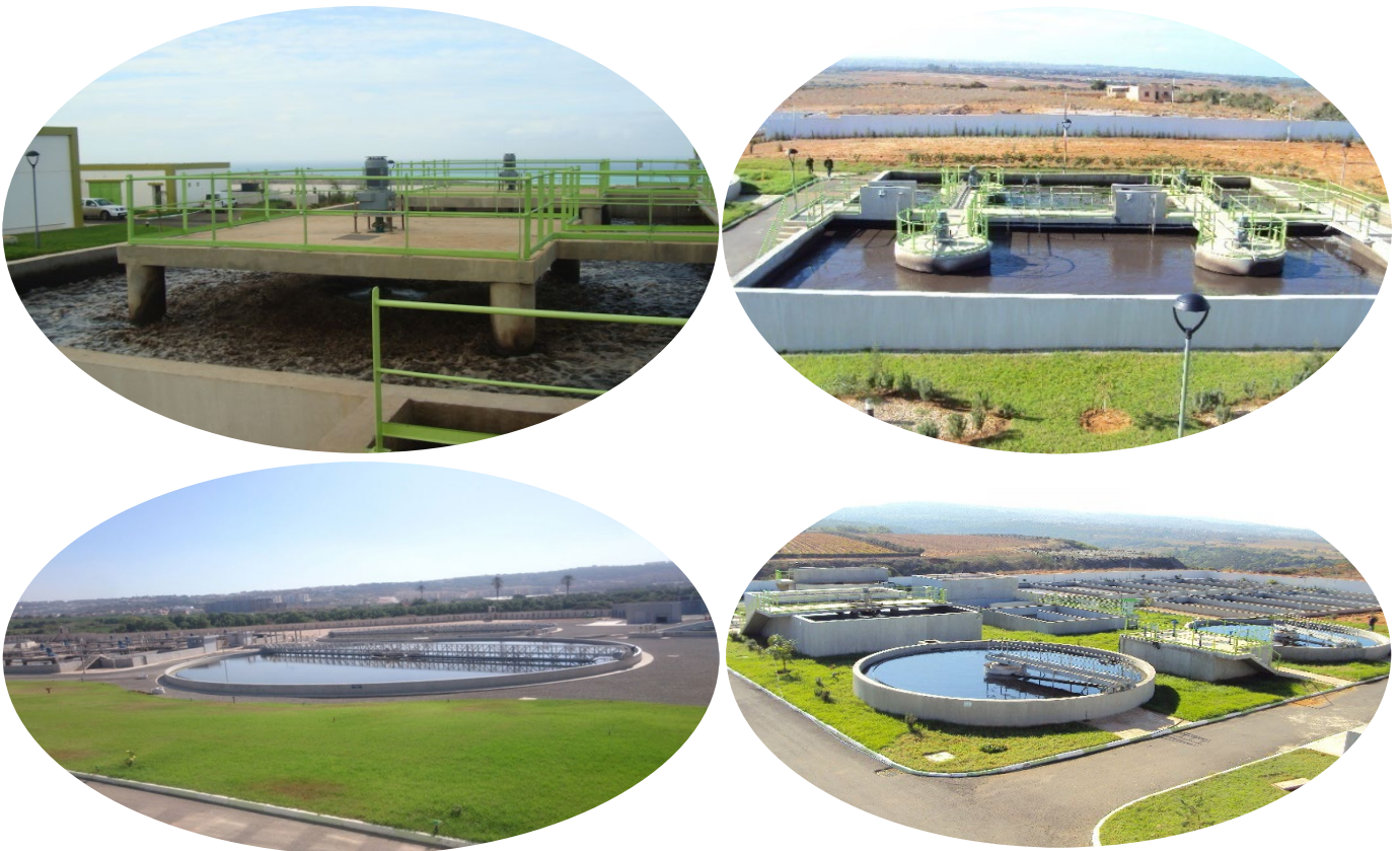
Figure 17 : Vues sur les stations d'épuration STEP de Mostaganem
