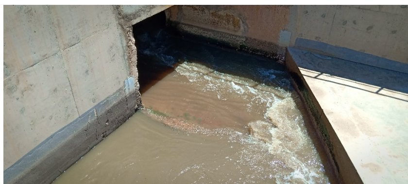
Figure 22 : Vue sur l'entrée de la station des eaux usées
