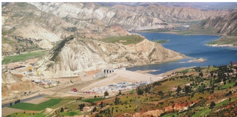
Figure 5 : Barrage de CHELIF d'une capacité de 50 Millions M 3
