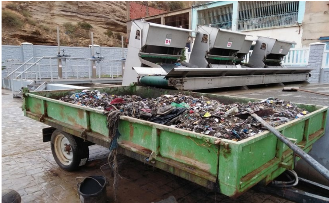
Figure 20 : Vue sur trois éléments de grillage fin
