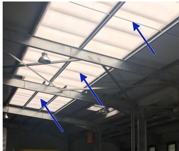
Figure III.5.: disposition des liernes
