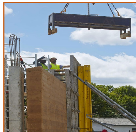
Figure 27 : Le coffrage métallique en Pisé.
