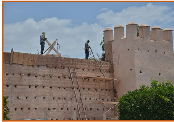
Figure 93 : Technique de construction de la muraille (pisé) .
