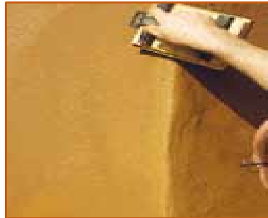
Figure 176 : Application de la couche de finition.
