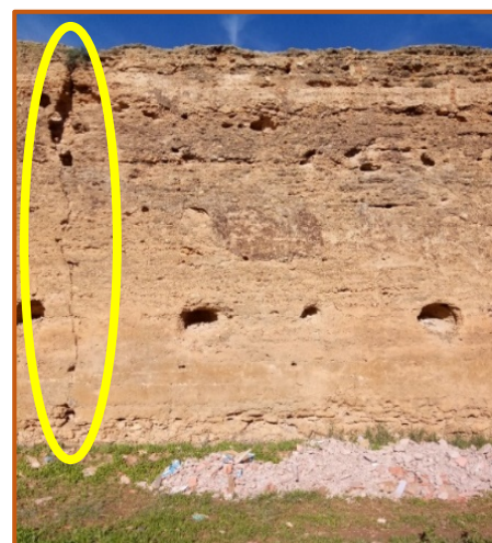
Figure 170 : la fissure sur la muraille d'Almohad , Sour ,Algérie.
