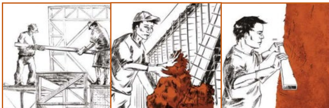
Figure 19 : Les étapes de construction en Torchis
