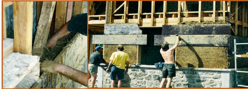
Figure 20 : Les étapes de construction en terre paille .
