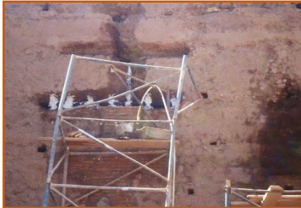
Figure 173 : Ouverture et application des agrafes.
