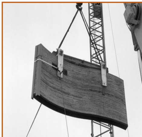
Figure 26 : Le pisé préfabriqué.
