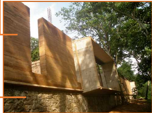
Figure 136 : Les murs en pisé.
