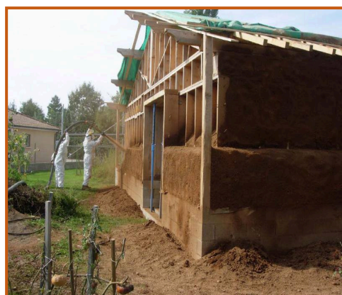
Figure 29 : La technique de terre projetée.
