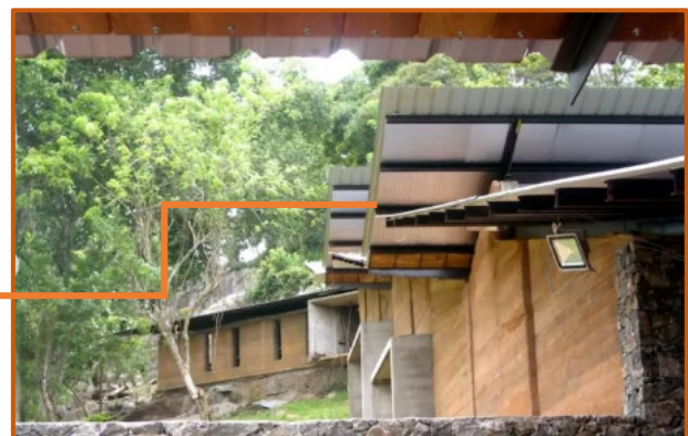
Figure 138 : La toiture du projet.
