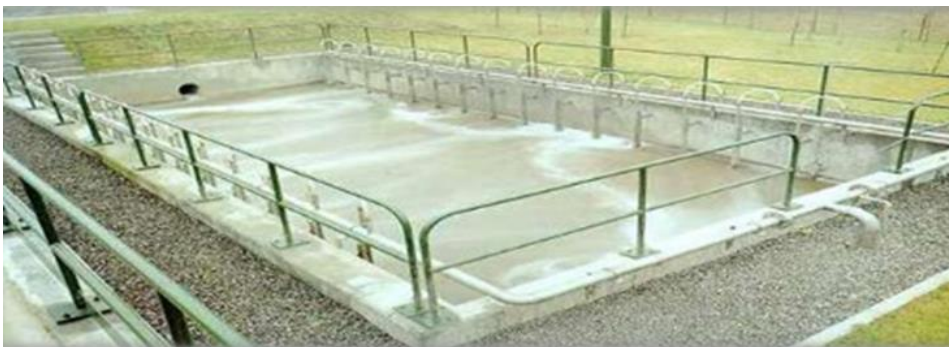
Figure 105 : le traitement secondaire.
