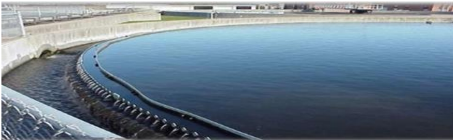
Figure104: le traitement primaire des eaux usées.
