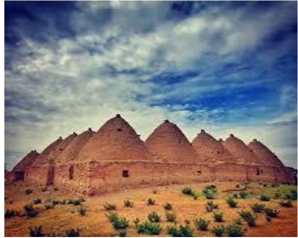
Figure 12 : Harran ; Vue sur l'extérieur.
