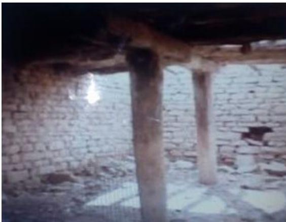
Figure41 : Système constructif du plancher
