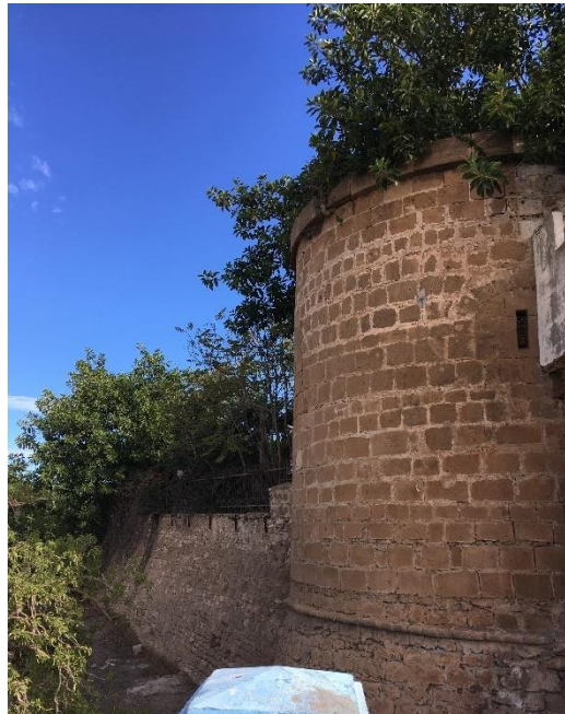
Figure 21 : photo montre de la tour
