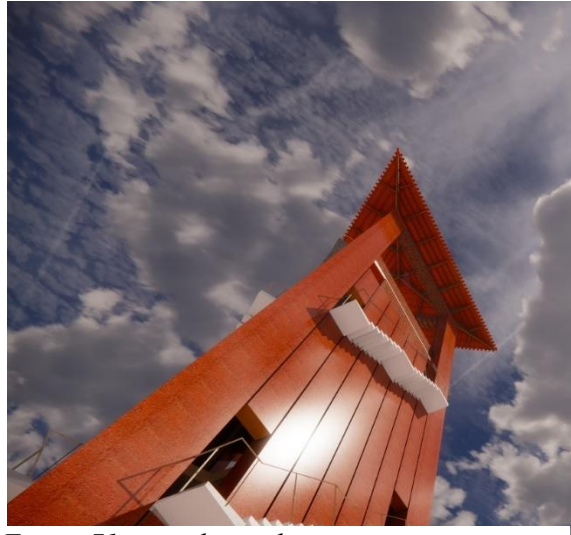
Figure 71 : vue depuis la tour
