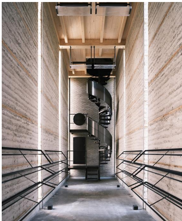
Figure 78 :Vue intérieure de la Kiln Tower
