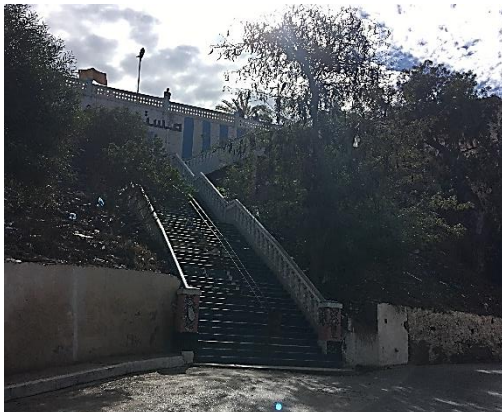
Figure 08 : Vue de l'escalier reliant la partie basse et haute
