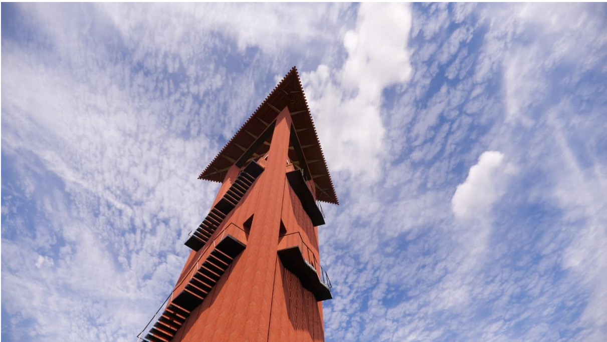
Figure 103 : Vue en contre-plongée depuis la base de la tour
