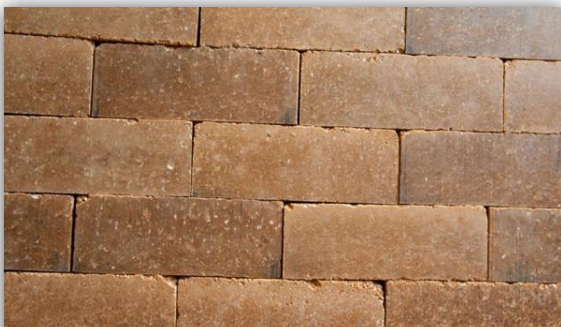
Figure 82 : mur en brique de terre cuite
