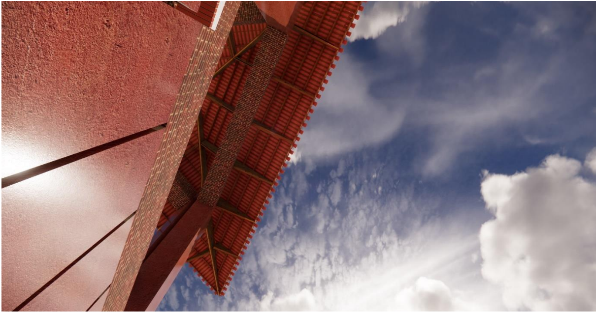
Figure 100 :Façade partielle de la tour
