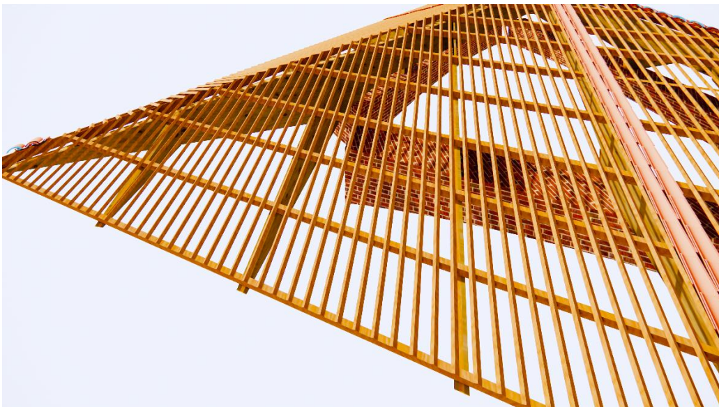
Figure 91: Charpente avant pose des tuiles
