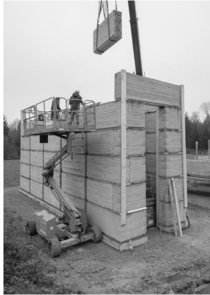
Figure 80 : Montage des éléments en terre crue compactée
