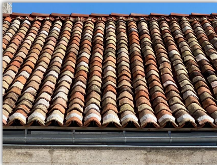
Figure 95 : photo de toit en tuiles canal
