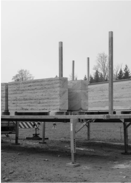
Figure 79: Préfabrication des murs en terre crue sur chantier.
