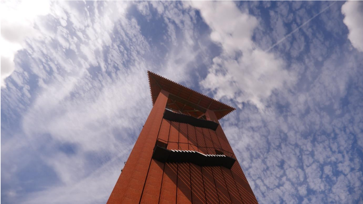
Figure 102 : Vue depuis un palier d'escalier vers le sommet
