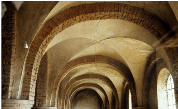
Figure 89 : photo dalles avec des voûtes d'arêtes
