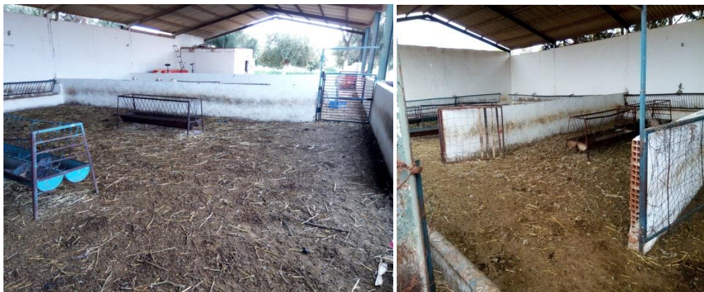
Figure (11) : bâtiment d'élevage
