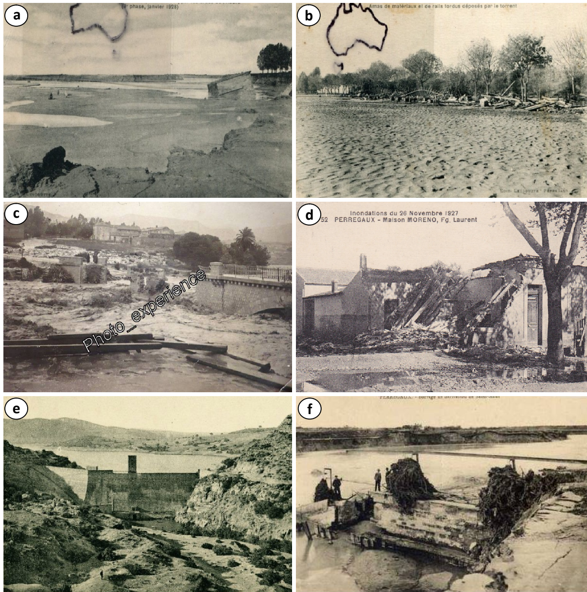
Figure 4.4- Les dégâts enregistrés dans la wilaya de Mascara suite aux crues de 1927 : (a) un pont détruit dans la plaine d'El Habra, (b) amas de matériaux et de rails tordus déposés par le torrent, (c) la destruction d'un pont à Bouhnifia, (d) une maison détruite par les crues à Mohammadia, (e) l'état du barrage de Saint-Maur en état normal, (f) le barrage après la rupture en décembre 1927 (Source : photos d'archives).
