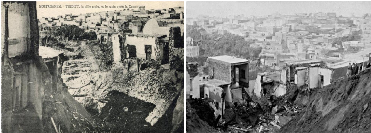
Figure 4.11- Vue sur Tigditt après la catastrophe (Source: photos d'archives).
