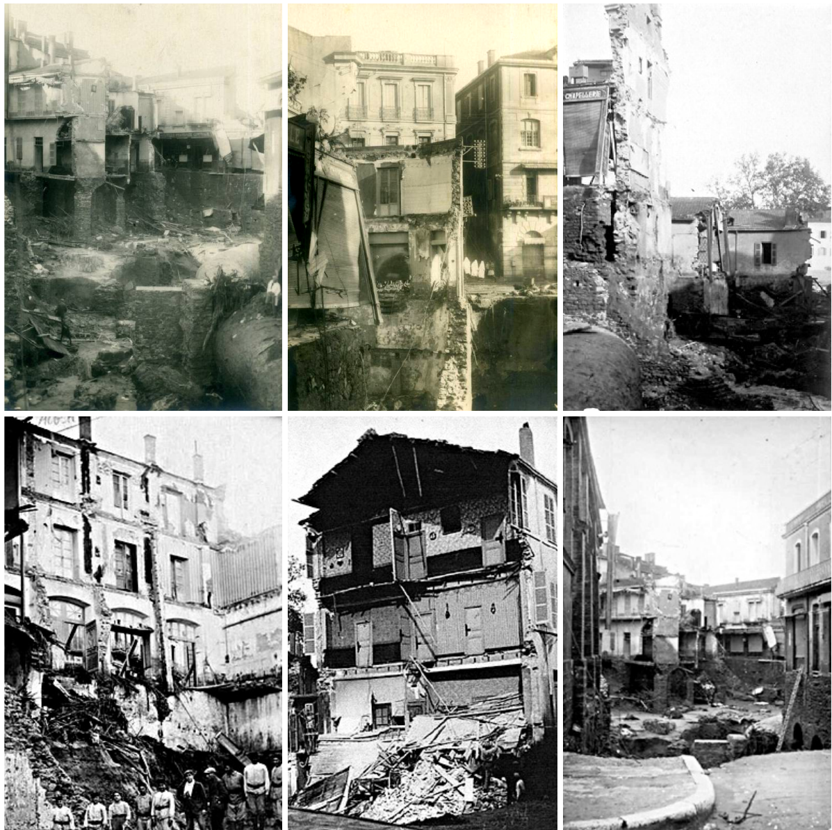
Figure 4.7- Les dommages causés par la crue du ravin de Aïn Sefra (Source: photos d'archives).
