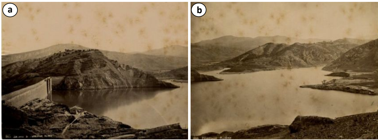
Figure 4.16- Vue sur le barrage de l'oued Fergoug en 1875 (Source : photos d'archives).
