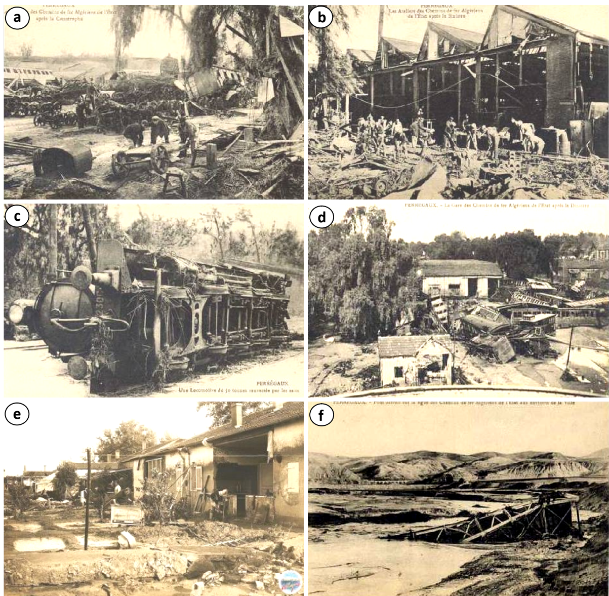
Figure 4.19- Les dégâts causés par l'inondation du 26/11/1927 à Mohammadia : (a) et (b) les ateliers des chemins de fer après la catastrophe, (c) une locomotive renversée par les eaux, (d) les dégâts au niveau de la gare, (e) les dégâts au niveau des fermes, (f) un pont détruit sur la ligne du chemin de fer (Source: photos d'archives).
