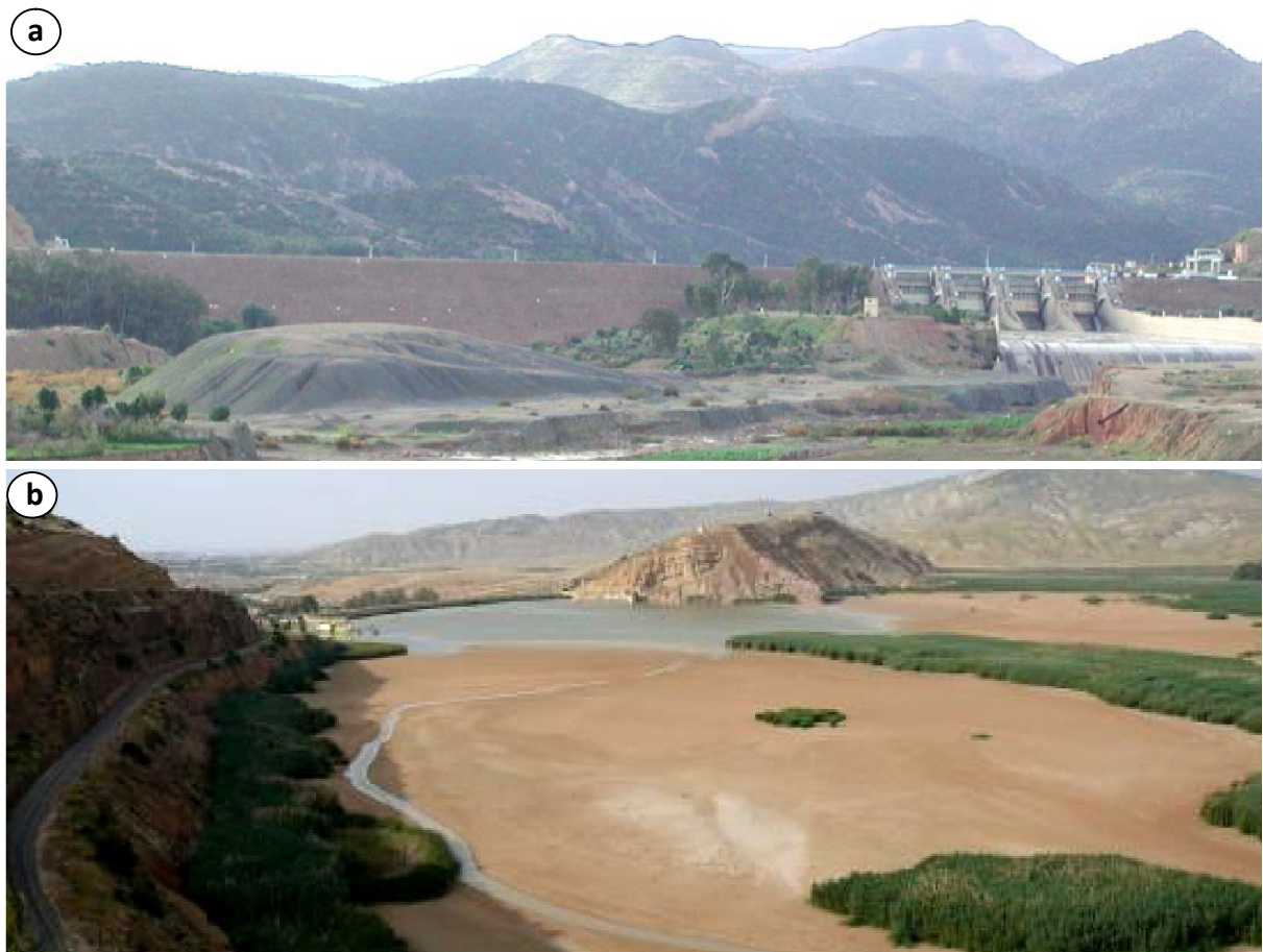
Figure 4.21- Etat actuel du barrage de Fergoug : (a) une vue sur la digue du barrage, (b) le taux d'envasement du barrage (Source: archives de presse).
