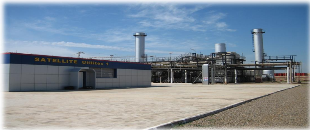
Figure-I-5- : Zone des utilités
