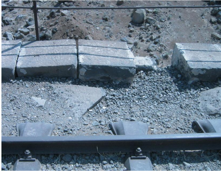
صورة رقم (4-14). تبين حفرة مع نزع أحجار الاطروفة
