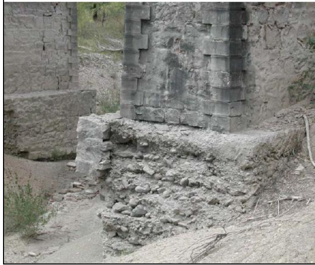
الصورة رقم (3-17). تبين تشقق عرضي في مركز الركيزة
