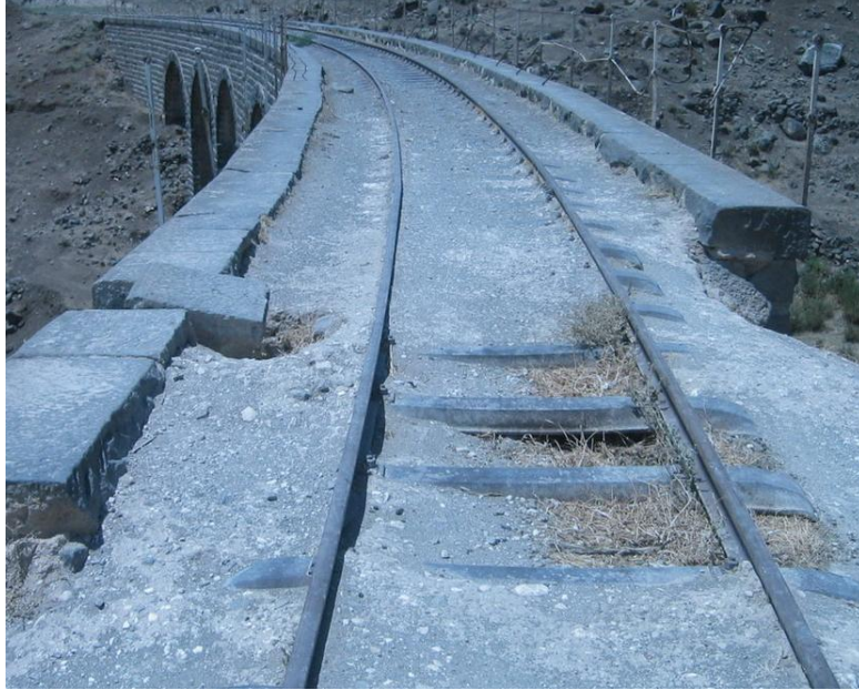
صورة رقم (3-2). تبيين تشوه سطح الجسر عند مدخله
