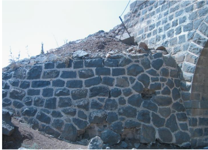
صورة رقم (4-11). تبين حالة التغطية الحجرية للركيزة الطرفية
