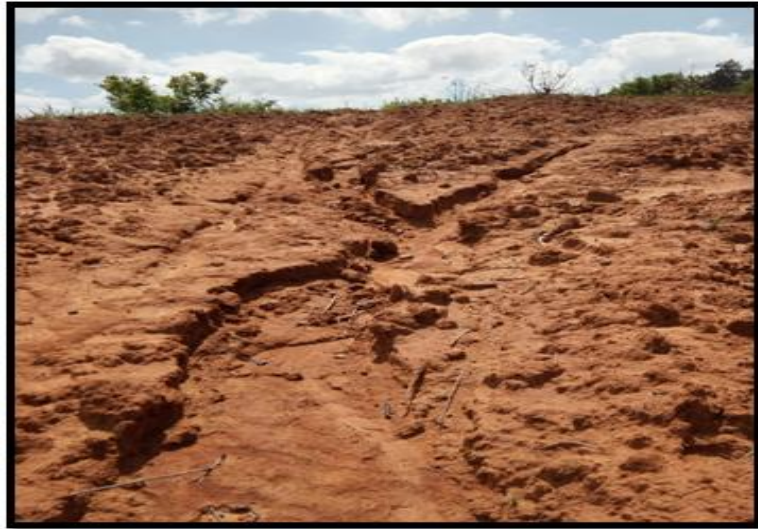
Figure 02. Début de creusement sur des terres agricoles dans la zone d'étude
