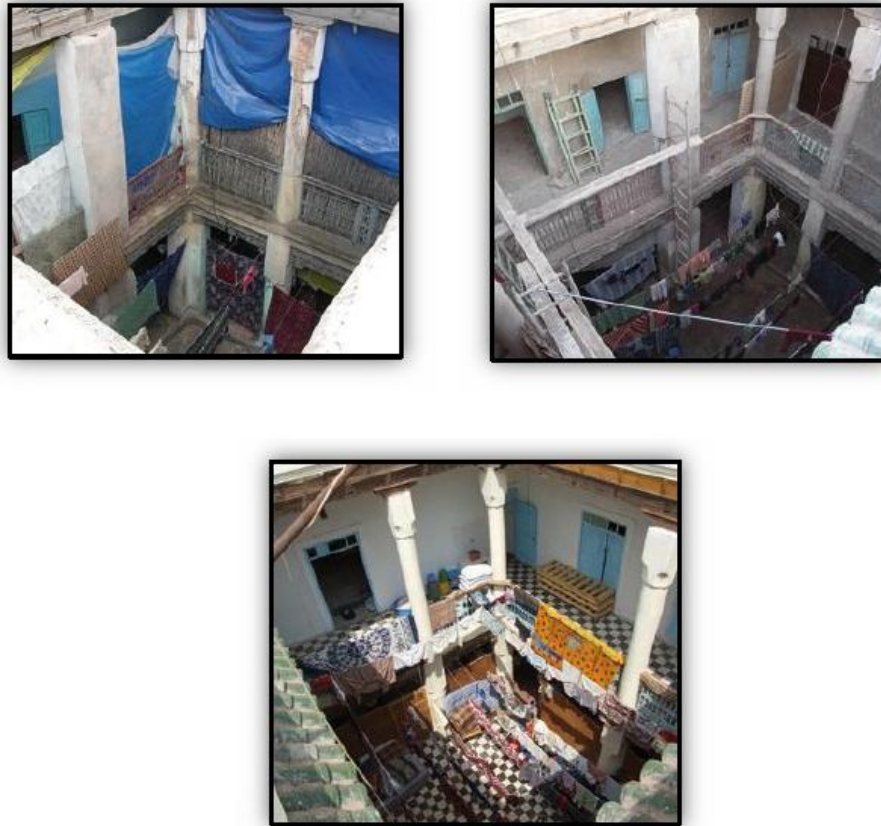
Photo 20 Les différentes phases de réhabilitation, avant, pendant et après les travaux.
