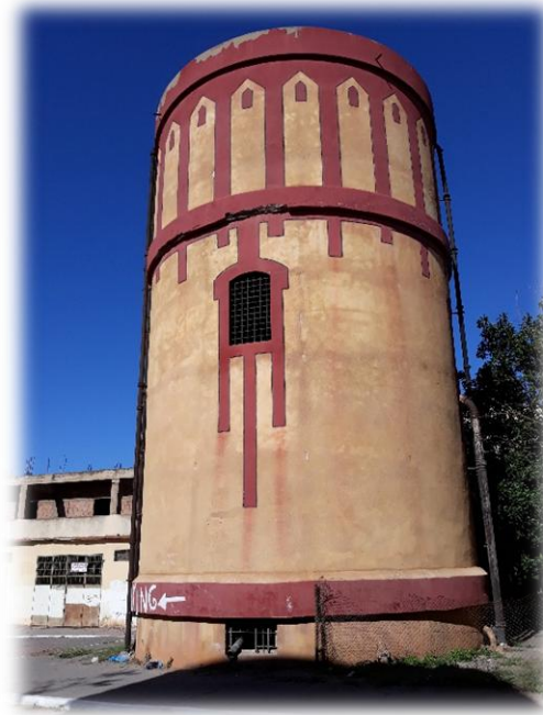
Photo 60 Le château d'eau.
