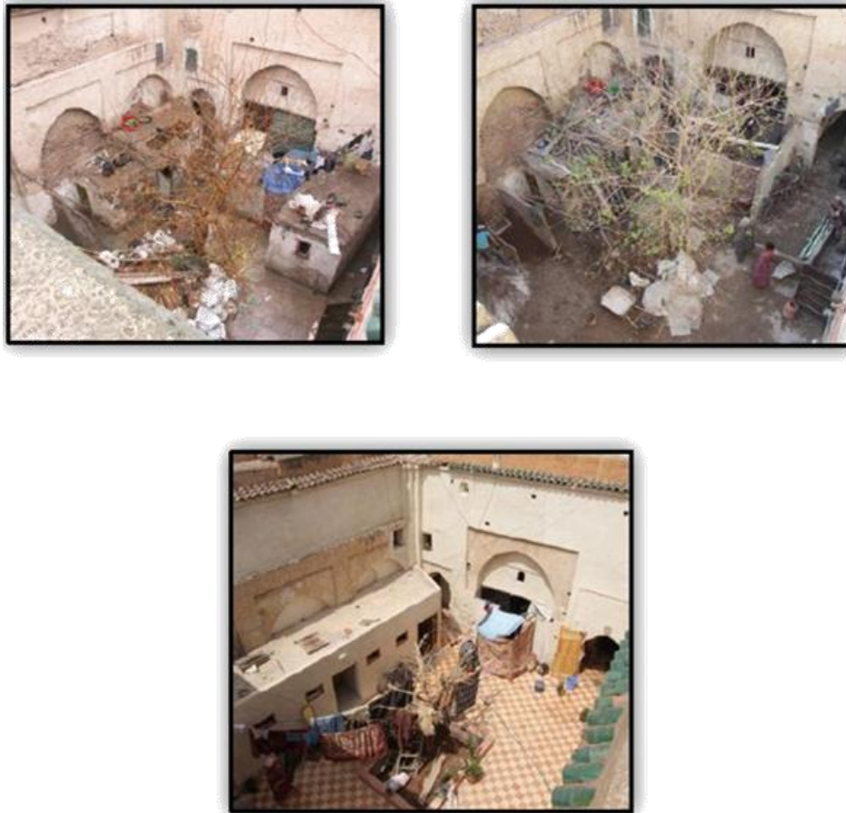
Photo 17 Les différentes phases de réhabilitation, avant, pendant et après les travaux.
