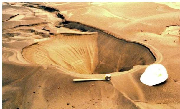
Figure 1.6 Ebullition de sable pendant le séisme de Loma Prieta aux Etats-Unis en 1989 près de l'extrémité nord de la piste principale de l'aéroport international d'Oakland (Source : USGS, 1989)
