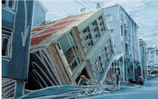
Figure 1.8 Bâtiment incliné du fait de la liquéfaction des sols au séisme d'Izmit en Turquie en 1999 (Source : BRGM, 1999)
