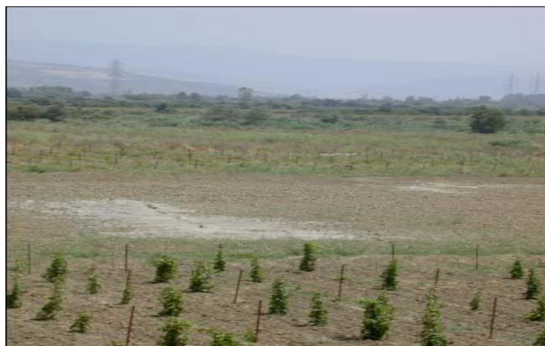
Figure 1.10 Ebullitions de sable dues à la liquéfaction près de la rivière d'Isser à Boumerdès en 2003 (Source : EERI, 2003)
