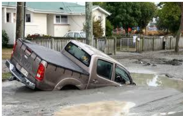
Figure 1.9 Véhicule enfoncé dans le sol suite à la liquéfaction à Christchurch, en Nouvelle Zélande en 2011 (Source : AAP, 2011)
