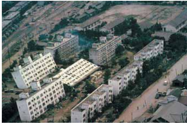
Figure 1.3 Bâtiments inclinés du fait de la liquéfaction des sols à Niigata au Japon en 1964 (Source : Steinbrugge Collection NISEE, 1964)
