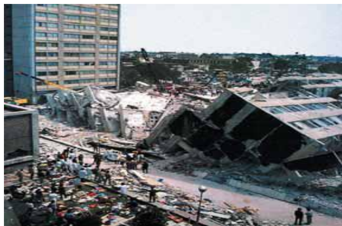
Figure 1.4 Bâtiments penchés et effondrés du fait de la liquéfaction des sols à Mexico en 1985. (Source: Global Institute for Energy and Environmental Systems, GIEES, 1985)
