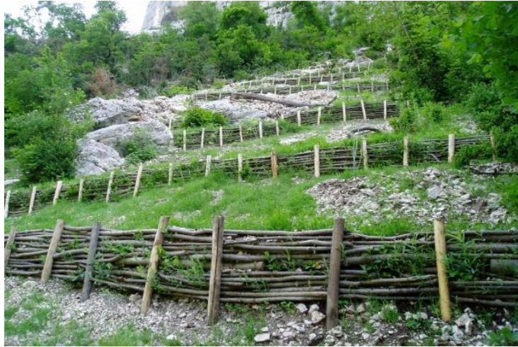
Figure 5. Des techniques éprouvées de génie végétal (ici des fascines) fascines en l'occurrence), mais un choix d'essences pouvant être remis en question par le changement climatique (Photo F. Rey.)
