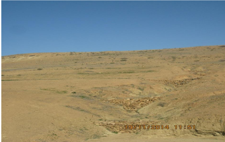
Photo.18. Correction des ravins par des pierres sèches.
