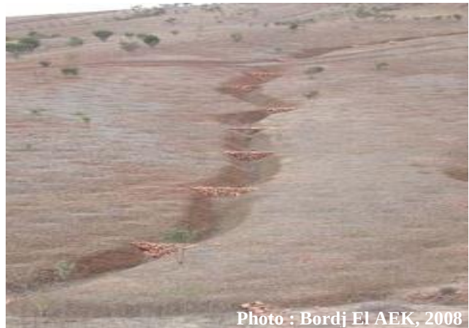
Photos 10. Correction torrentielle.
