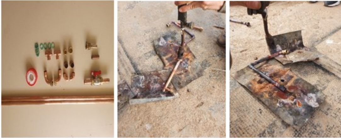
Figure 3.3 Soudage des tubes en cuivre.
