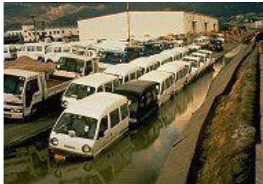
Figure I-12 Endommagement des routes : Baisse du niveau de la route due à l'épandage latéral (Alisha, 2004).
