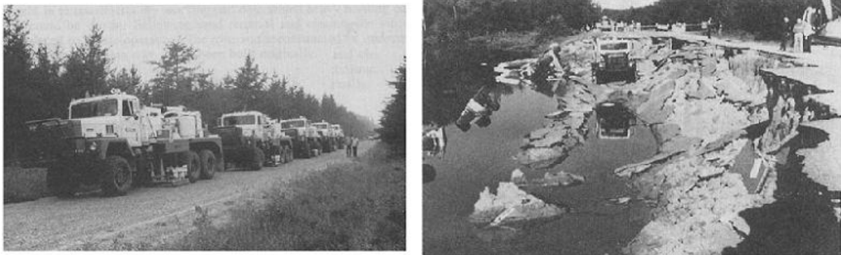
Figure I-6 Rupture de remblai sur le lac Ackermann déclenché par camions de vibro-sols (Jefferies et Been, 2006)
